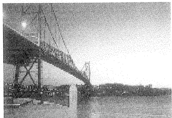
Figura 2.11 - Ponte Hercílio Luz.
