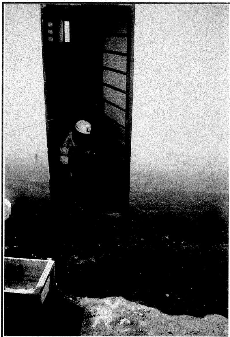
Figura 30 - Sistema construtivo convencional - padrão COHAB. Dispositivo para marcar a inclinação da porta de 60° com o plano da parede.
