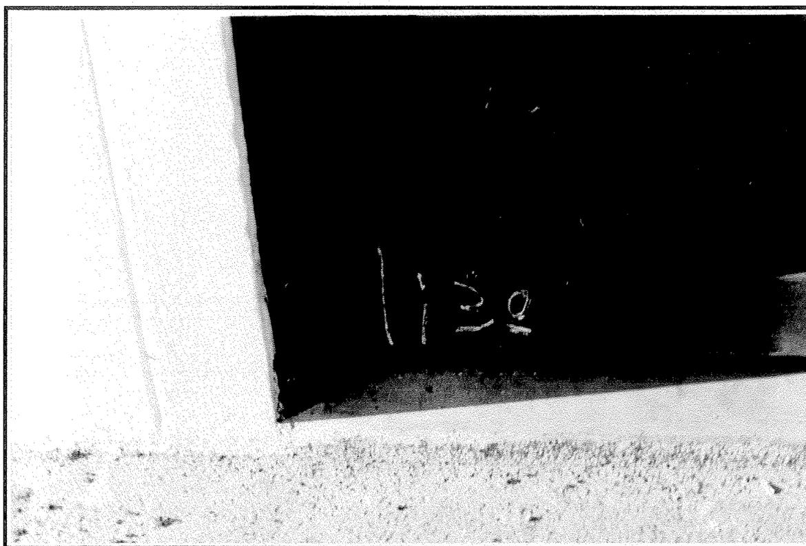
Figura 33 - Sistema construtivo I. Detalhe da ruptura da solda no canto inferior da folha.
