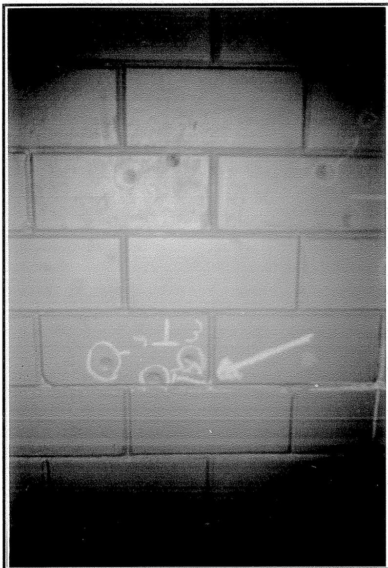
Figura 23 - Sistema construtivo D. Mossas produzidas pelos impactos.
