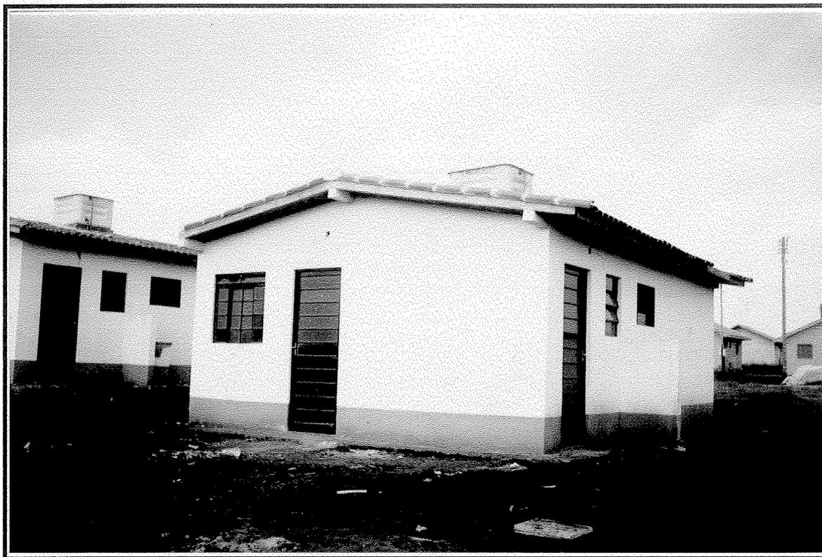
Sistema construtivo **G** - painéis pré-fabricados de poliestireno expandido e tela de aço, revestidos com argamassa, jateada com fibras de polipropileno.
