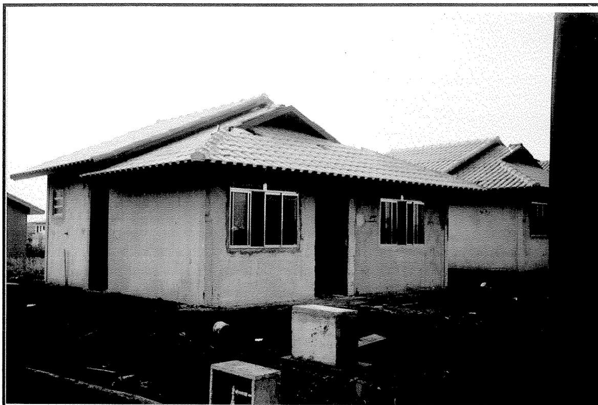
Sistema construtivo **C** - painéis autoportantes, tipo "sandwich", estrutura interna de madeira tratada e recoberta por chapa tipo "Hard Board", revestida com argamassa epóxica.
