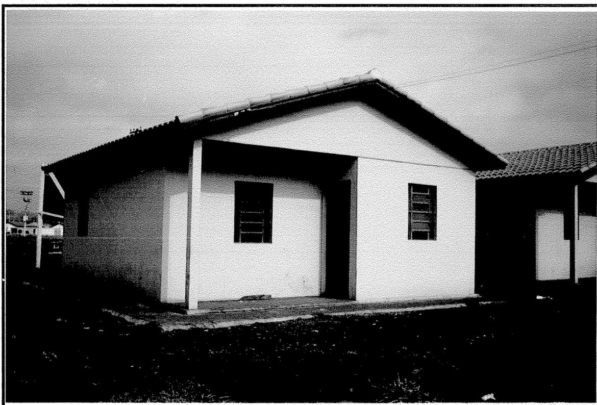
Sistema construtivo **F** - blocos cerâmicos, com encaixe macho/fêmea, permitindo a superposição e o intertravamento, dispensando o uso da argamassa.
