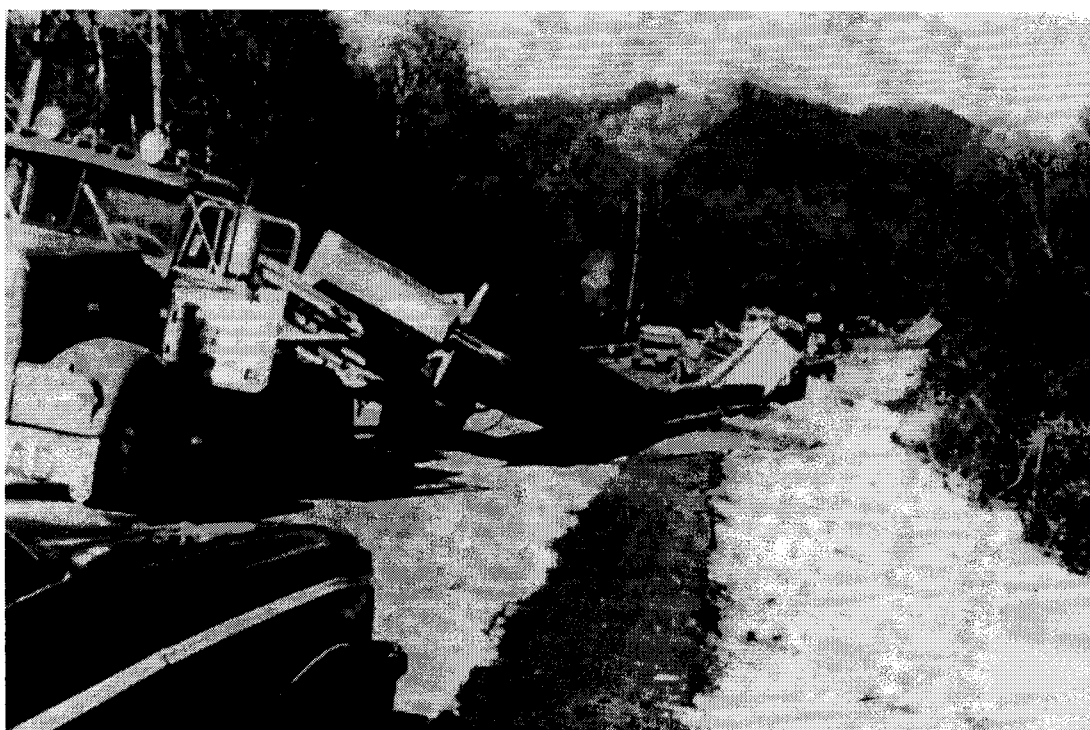
Figura 1.2 - Colapso de uma viga pré-moldada de concreto durante o transporte. [ IMPER & LASZLO (1987) ]
