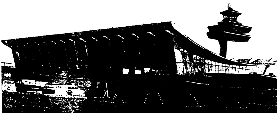
Figura 2.4.1.5 - Obra em fase final de construção.
