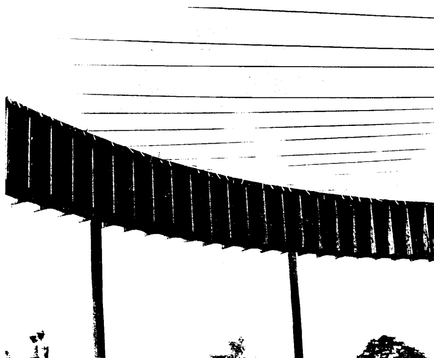
Figura 2.4.2.1 - Anel externo com os cabos ancorados.
