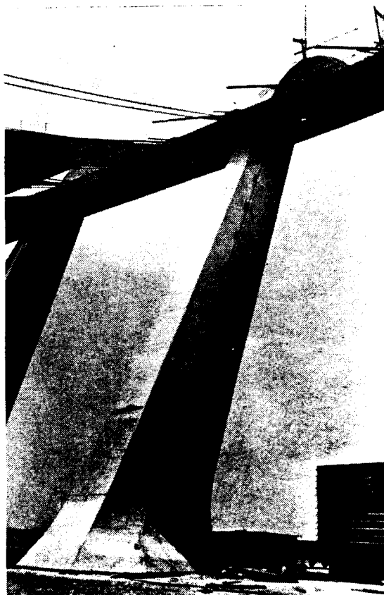
Figura 2.4.1.2 - Pilares e chapas onde são ancorados os cabos.
