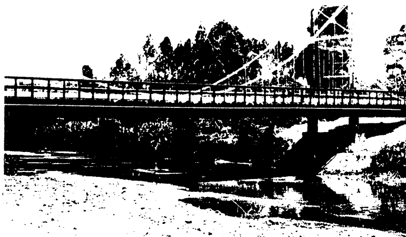
Figura 4.2: Ponte pênsil sobre o Rio Tietê, São Miguel Paulista - SP. (HELLMEISTER, CALIL & LAHR, 1977).
