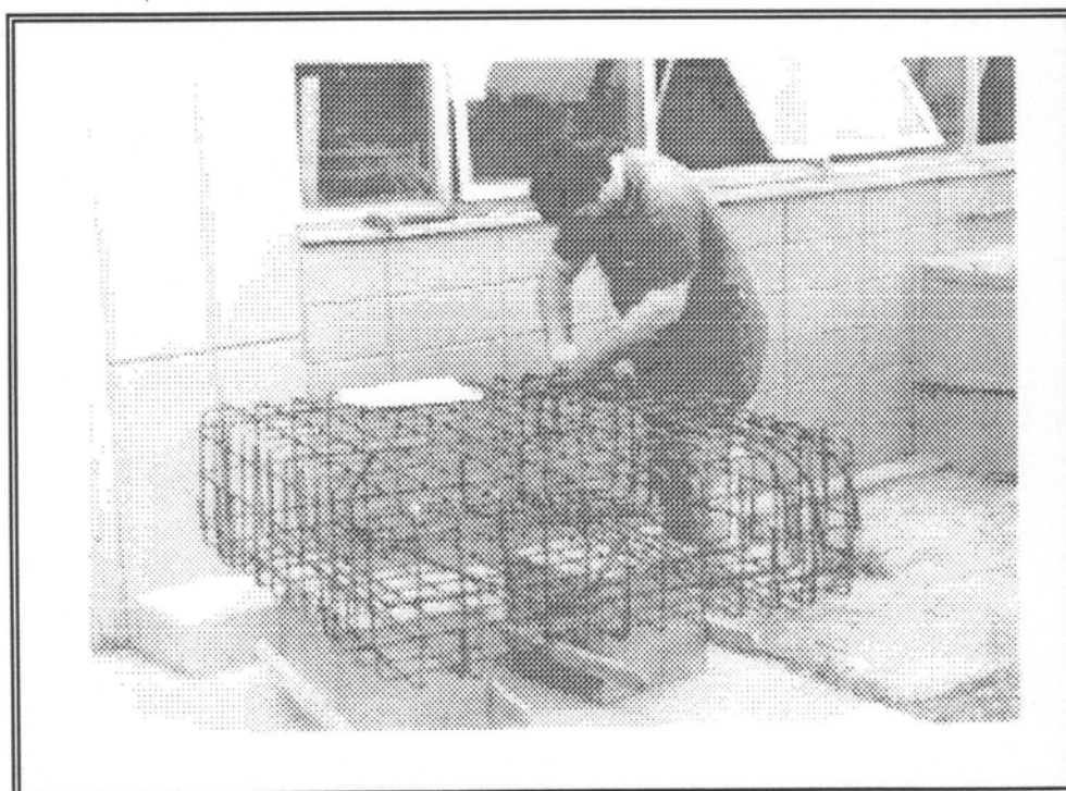
Foto 4.10 - Montagem da armadura de um bloco.
