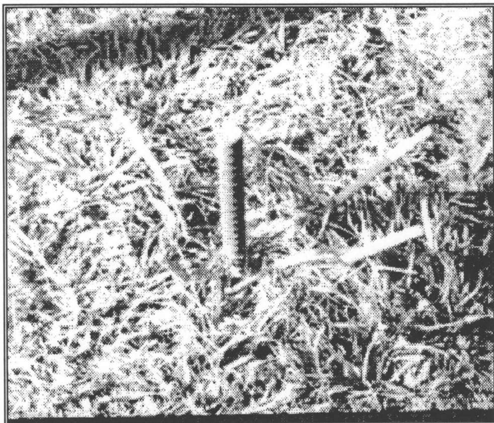
Foto 4.9 - Estaca STRAUSS pronta, com tirante
