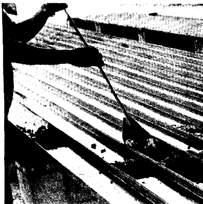
FIGURA 5.3. - LIMPEZA DAS FÔRMAS, LIMA (1991)
