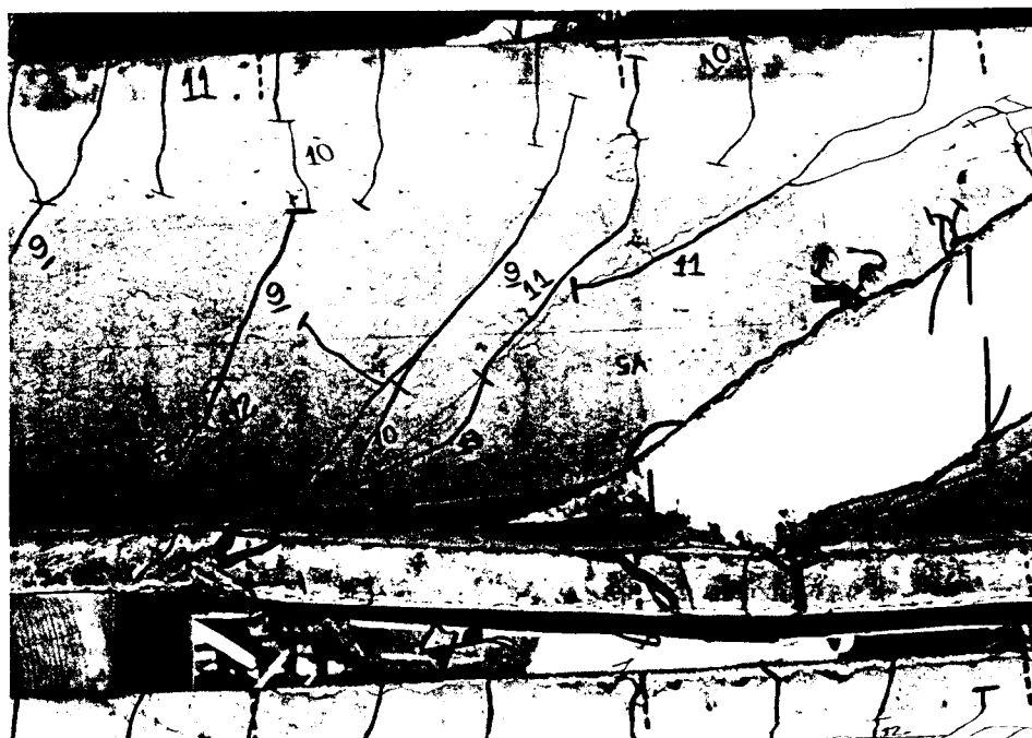
Foto 5.15 - Detalhe da região da ruptura do modelo V5
