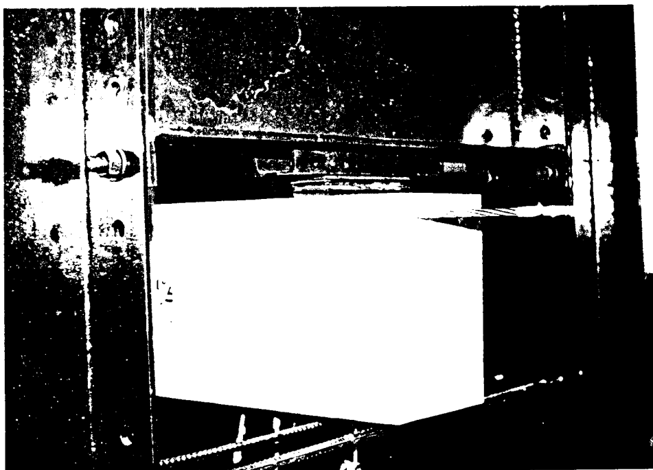
Foto 5.6 - Detalhe do apoio formado pelas placas de neoprene
