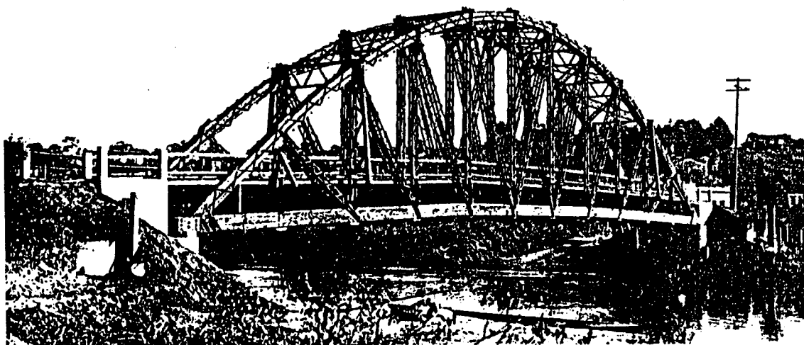
FIGURA 3.16 - Ponte Grande , rio Tietê, entre São Paulo e Guarulhos.
