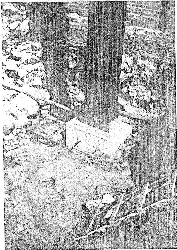
LIGAÇÃO TORRE METÁLICA - FUNDAÇÃO DE CONCRETO
