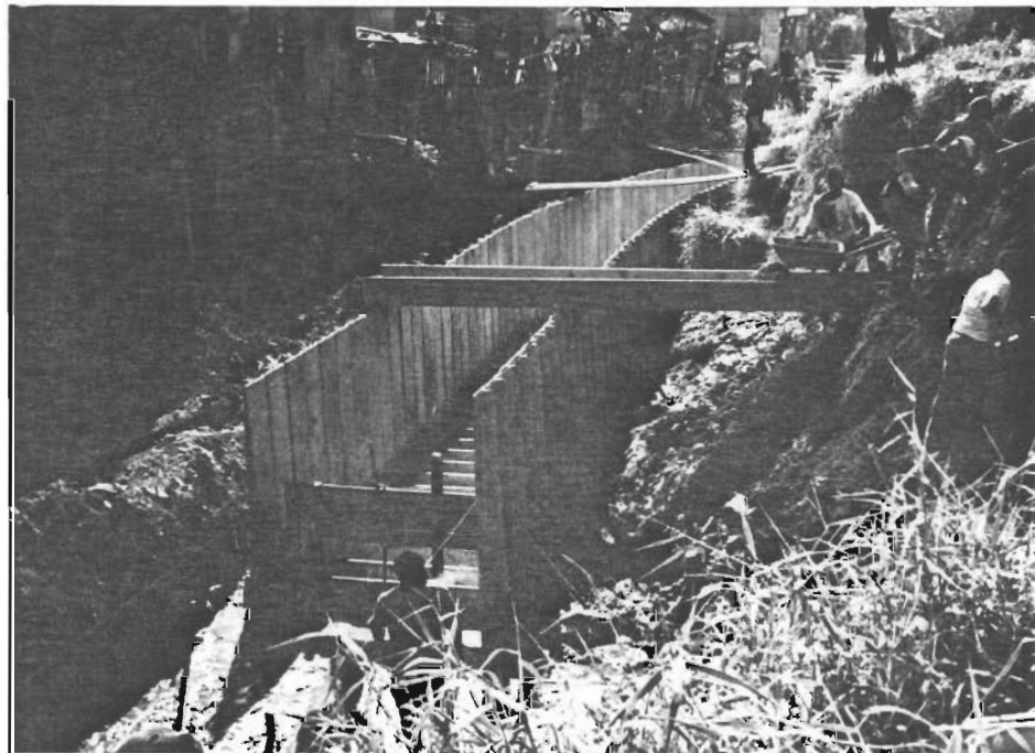
Foto 2.1 - Montagem do sistema de canalização..
