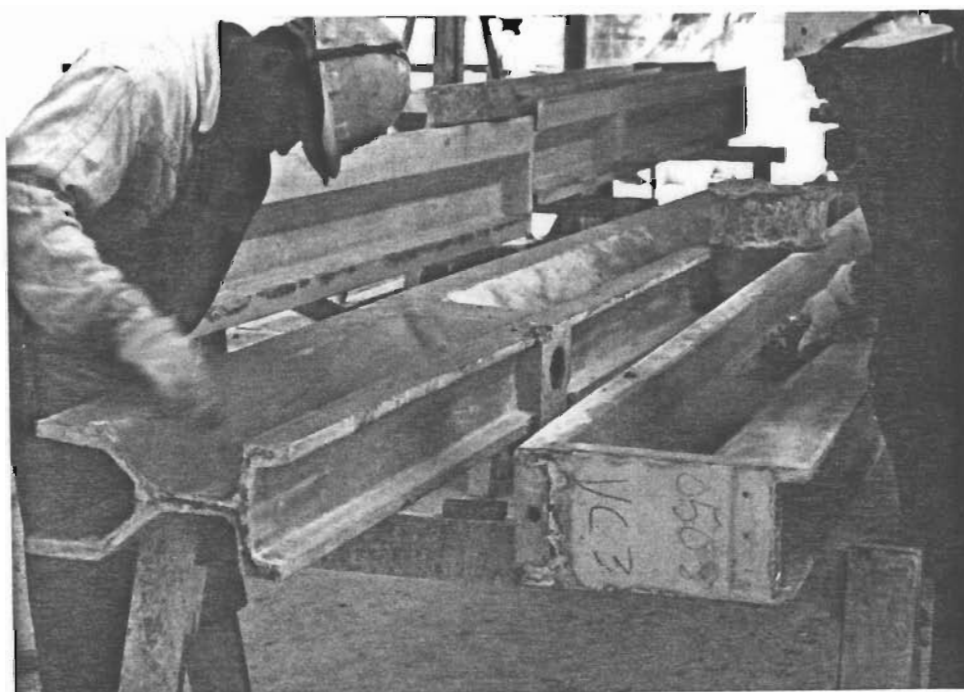
Foto 4.18 – Peça pré-fabricada sendo estucada.
