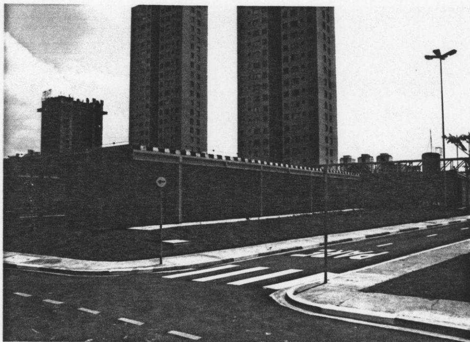
Foto 2.3 – Edificação em São Paulo construída com o sistema de equipamentos sociais.
