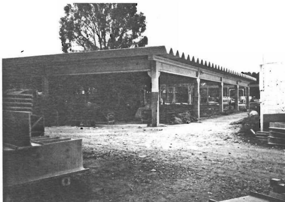
Foto 3.10 – Vista do galpão de produção com fôrmas fixas do Cedec/Emurb..
