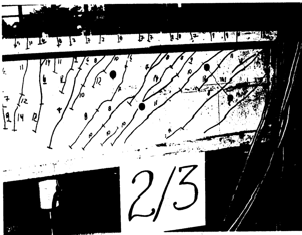
FOTOGRAFIA 6.8 - ESPAÇAMENTO DAS FISSURAS DO MODELO 2/3
