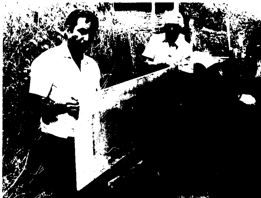
FIG. 16. A PLACA DE FACE, PRÉ-MOLDADA COM 12,7MM. DE ESPESSURA, ERA POUCO RÍGIDA, NECESSITANDO SER TRANSPORTADA EM "ESPELHO".
