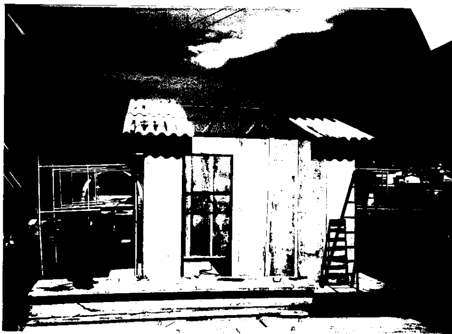
FIG. 144. INÍCIO DA COBERTURA.
