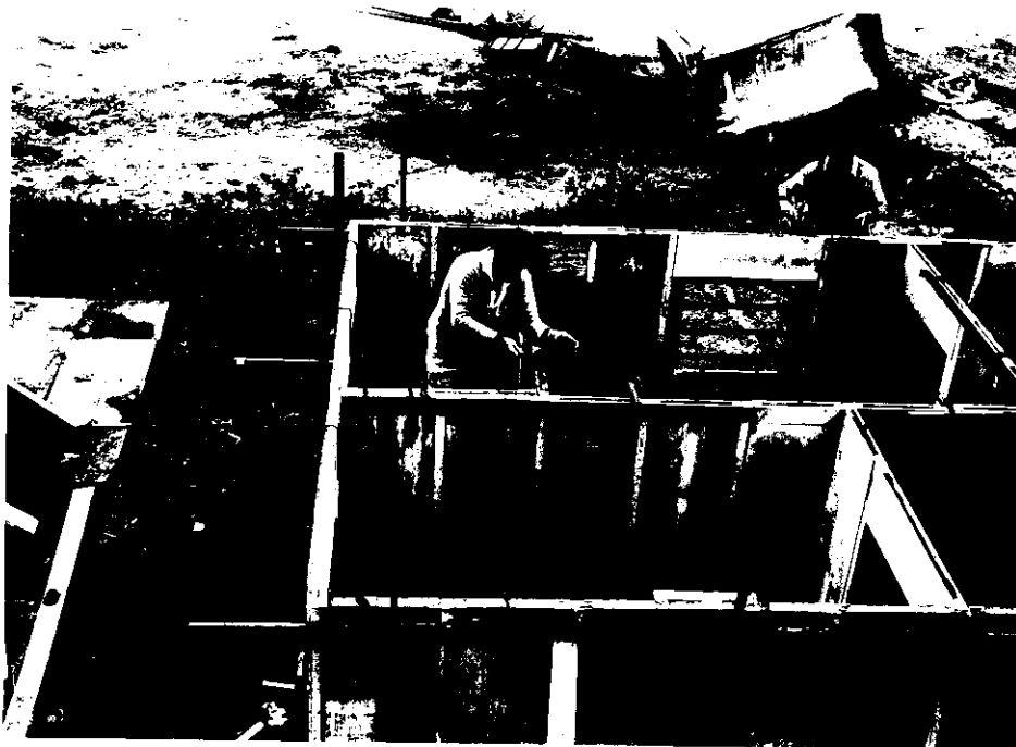
FIG. 125. CONCRETAGEM DA CINTA.
