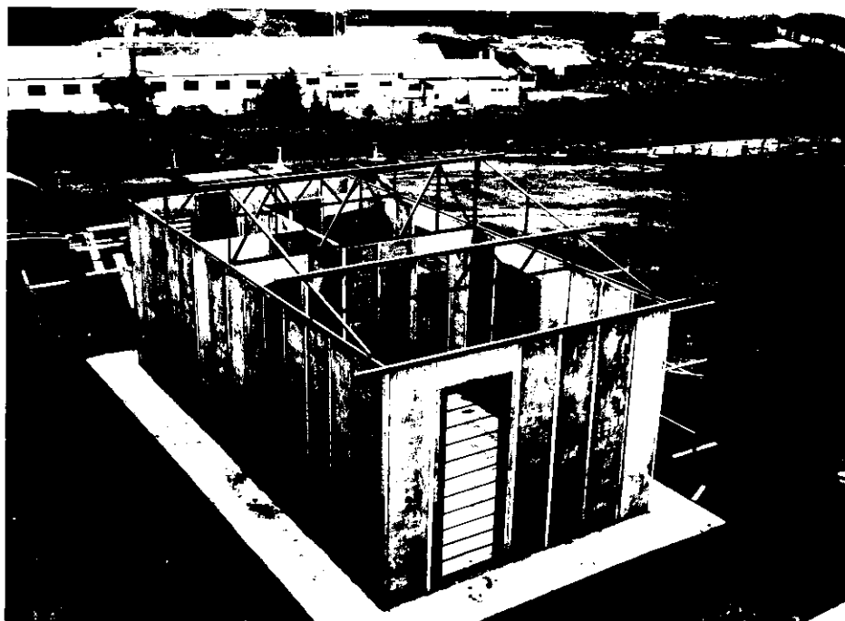
FIG. 142. A ESTRUTURA DA COBERTURA.
