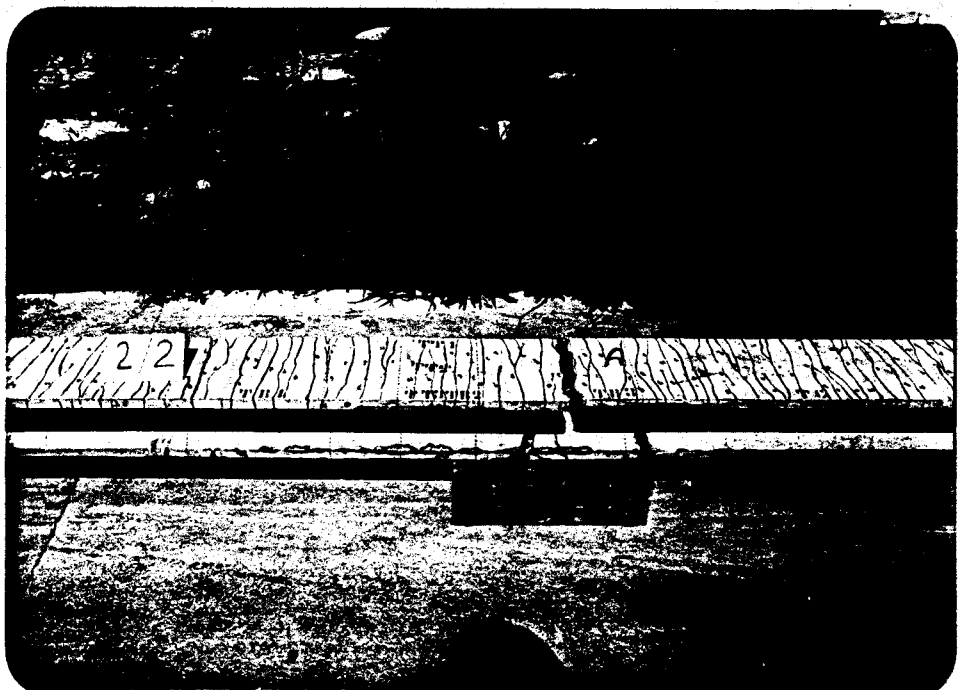
Foto 6.8 - Configuração de fissuras final do modelo 2/2, armado com tela soldada ensaiado por Giongo (22) .
