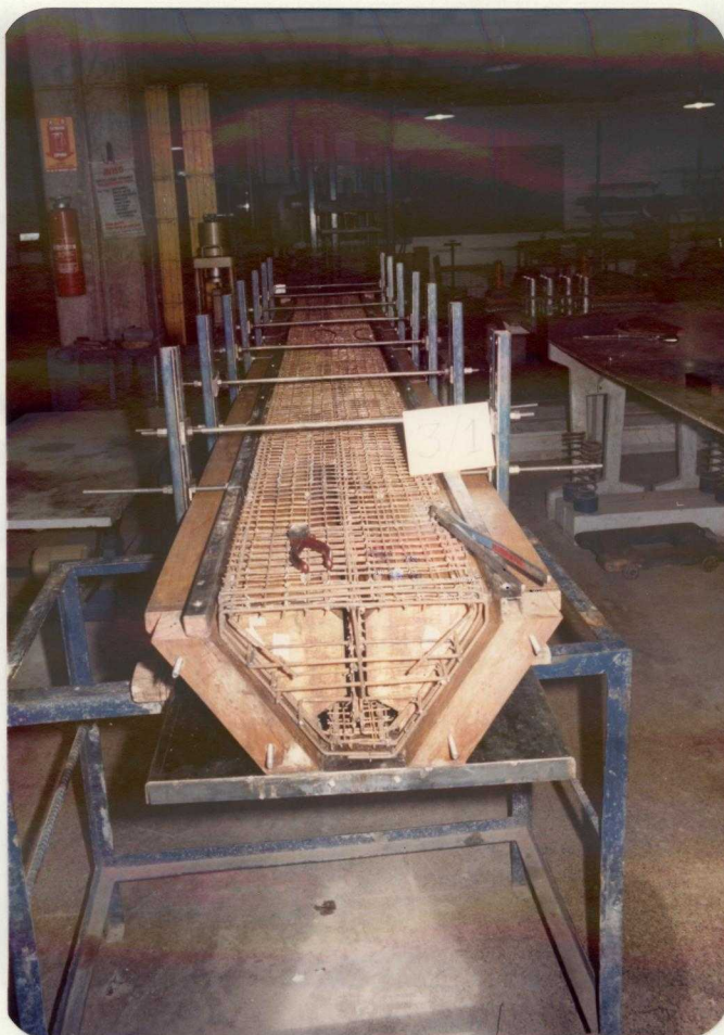
FOTOGRAFIA 11 - FÔRMA UTILIZADA PARA MOLDAGENS DOS MODELOS DAS SÉRIES 2,3,4 E 5.
