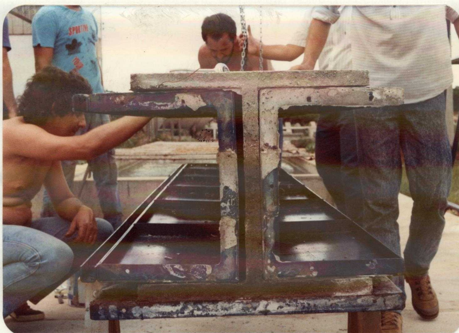
FOTOGRAFIA 10 - RETIRADA DA FACE LATERAL DA FÔRMA DE UM DOS MODELOS DA SÉRIE 1
