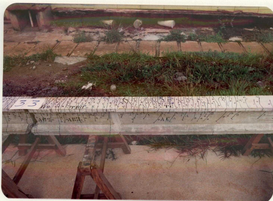
FOTOGRAFIA 40 - DETALHE DA FISSURAÇÃO DO MODELO 3/3
