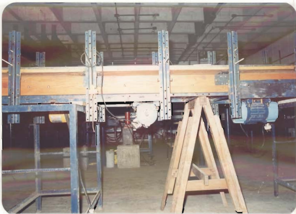
FOTOGRAFIA 4 — DETALHE DE FIXAÇÃO DOS VIBRADORES
