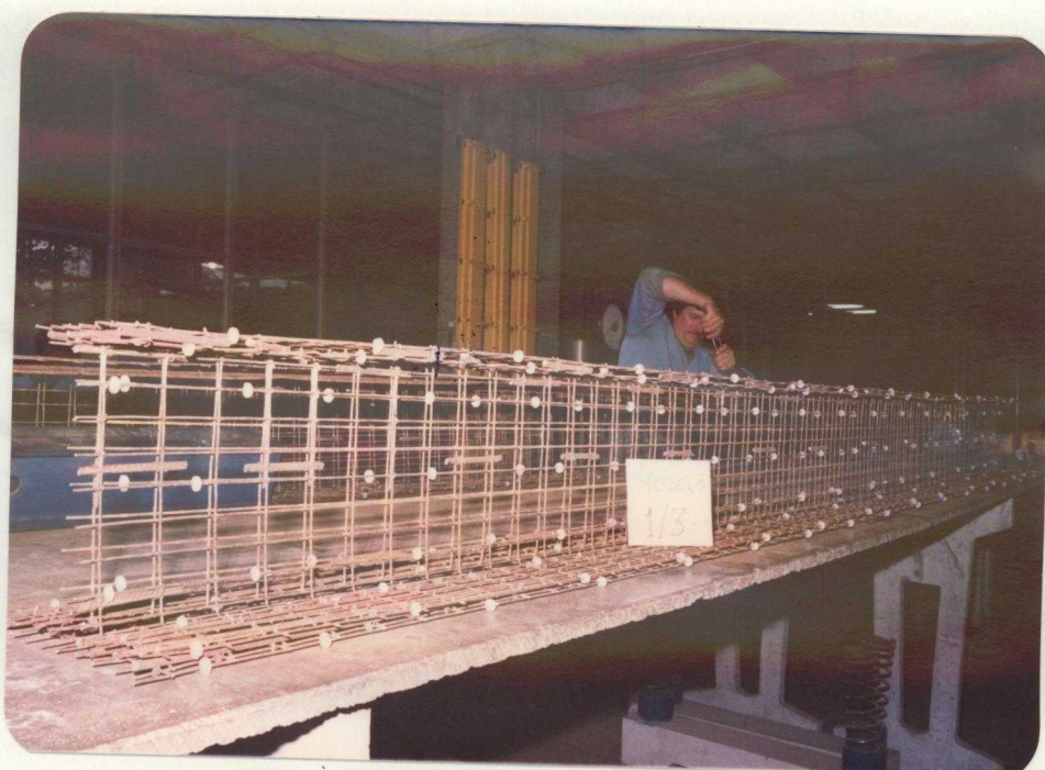
FOTOGRAFIA 02 - MONTAGEM DA ARMAÇÃO
