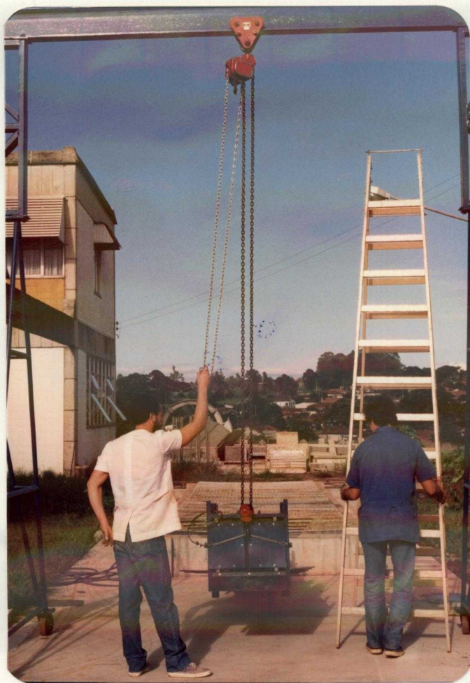
FOTOGRAFIA 05 - IÇAMENTO DA FÔRMA DE UM DOS MODELOS DA SÉRIE 1
