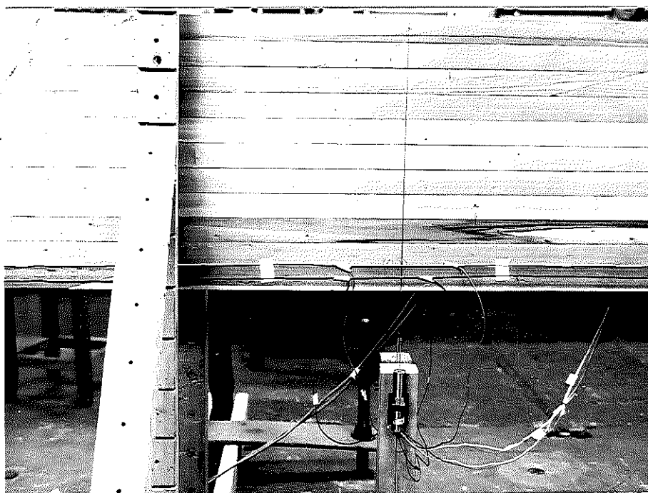
Fig. (5.13)- Instalação dos LVDTs.
