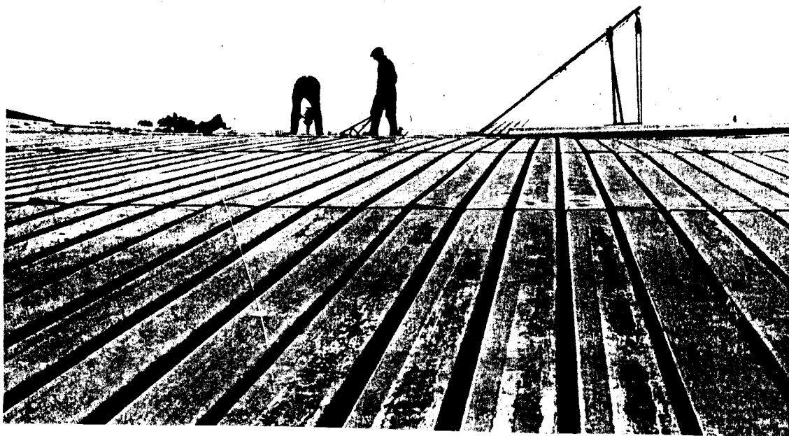
FIG. 1.15- Detalhe das telhas metálicas antes da aplicação do material isolante e impermeabilizante
