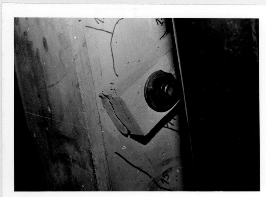
FOTO 6 - Outro aspecto da articulação sapata/tirante indicada na foto anterior. Observa-se também o esmagamento da ponta do tirante em razão da rotação em torno desta e as fissuras de cisalhamento marcadas na sapata.
