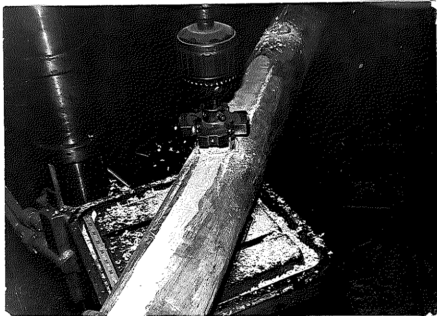
Fig. 98-Preparação do sulco para colocação do anel
