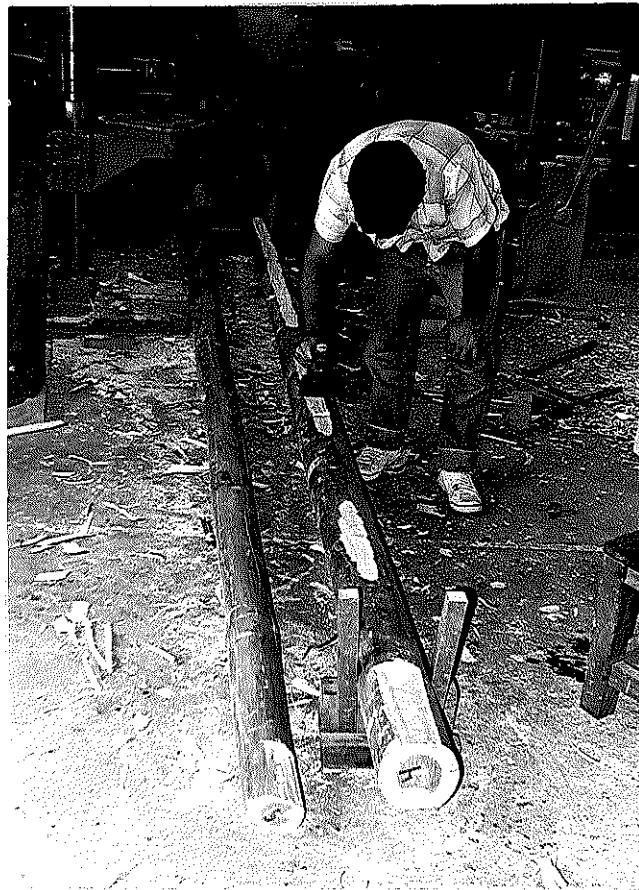
Fig. 96 -Aparelhamento dos postes com enxô
