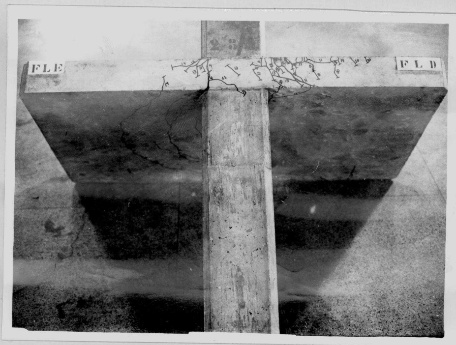
Fig. 3.1.5.b - Fissuração na face lateral do modelo EdL 23/1.
