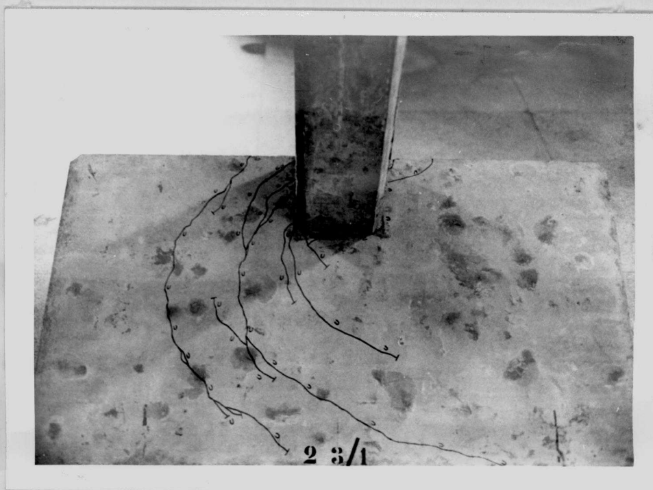
Fig. 3.1.5.c - Fissuração na face inferior do modelo EdL 23/1.
