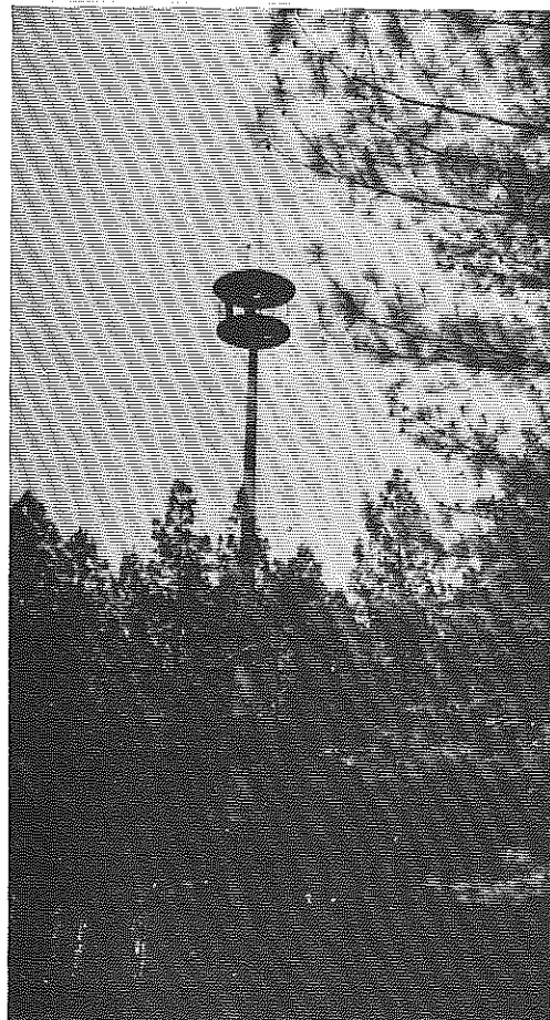
FIG.5.3 - TORRE DE CONCRETO.
