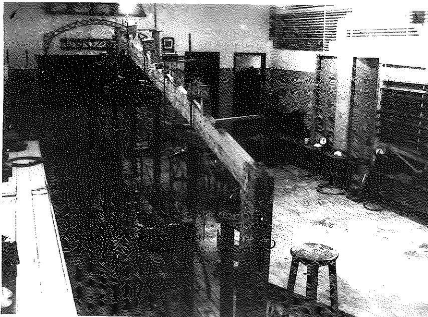
Figura 22 - Pórtico de madeira laminada, cavilhada e colada. Modelo reduzido-ensaio (22).
