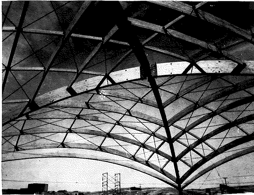
Figura 9 - Cúpula esférica (Domo Lamelar) construído pela Rilco Laminated Products, Inc. (9)
