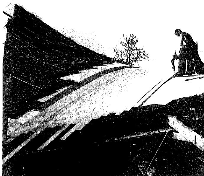
Figura 18 - Parabolóide Hiperbólico formado por tábuas sobrepostas em direções perpendiculares (18).
