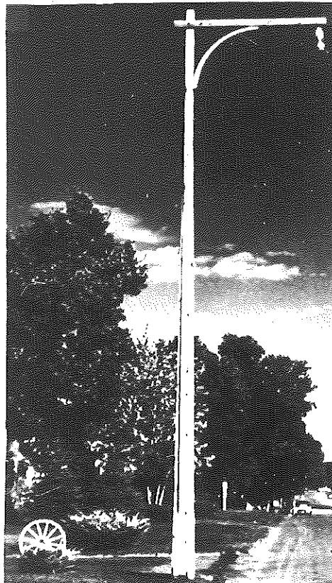
Figura 16 - Poste de madeira laminada, fabricado pela Rilco Laminated Products, Inc. (16).
