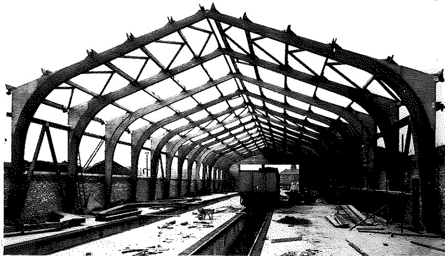
Figura 2 - Pórtico utilizado na construção da British Railways Diesel Electrical Depot, Longsight, Manchester, fabricado pela Kingston Ltda.(2).
