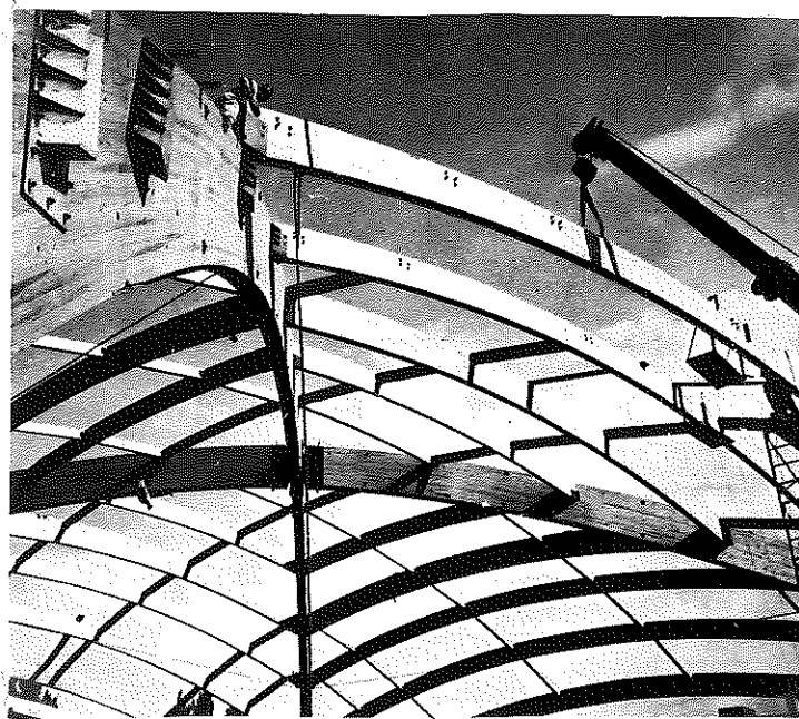
Figura 1 - Arco de 90 metros de corda fabricado pela Timber Structures; Inc. (1)
