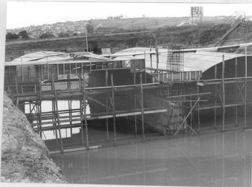
Foto 2.7 - Galeria metálica em arco em substituição a viaduto convencional (a água que aparece estava empoçada por ocasião da foto).
