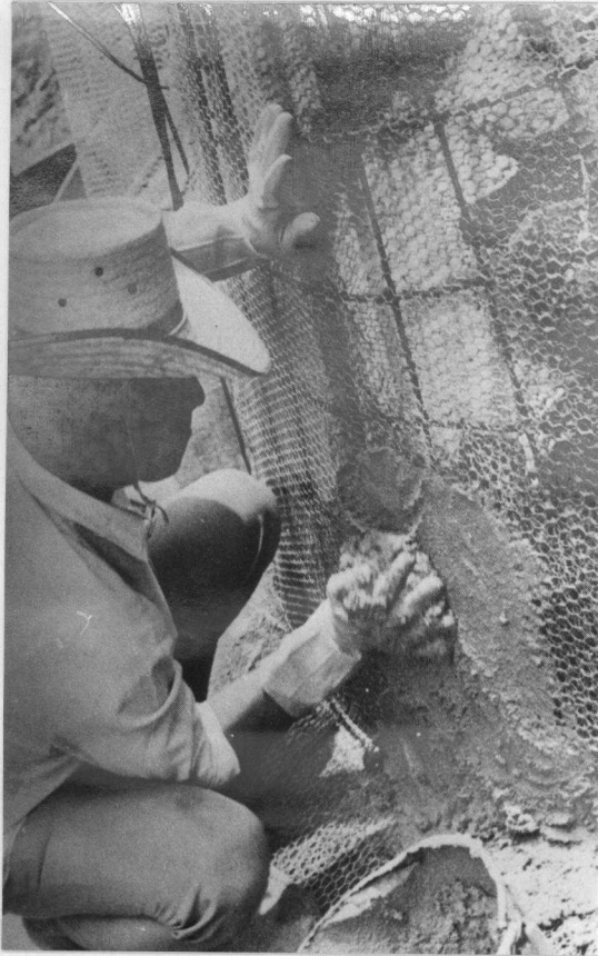
Foto 5.3 - Construção de silo de pequeno porte 56 .
