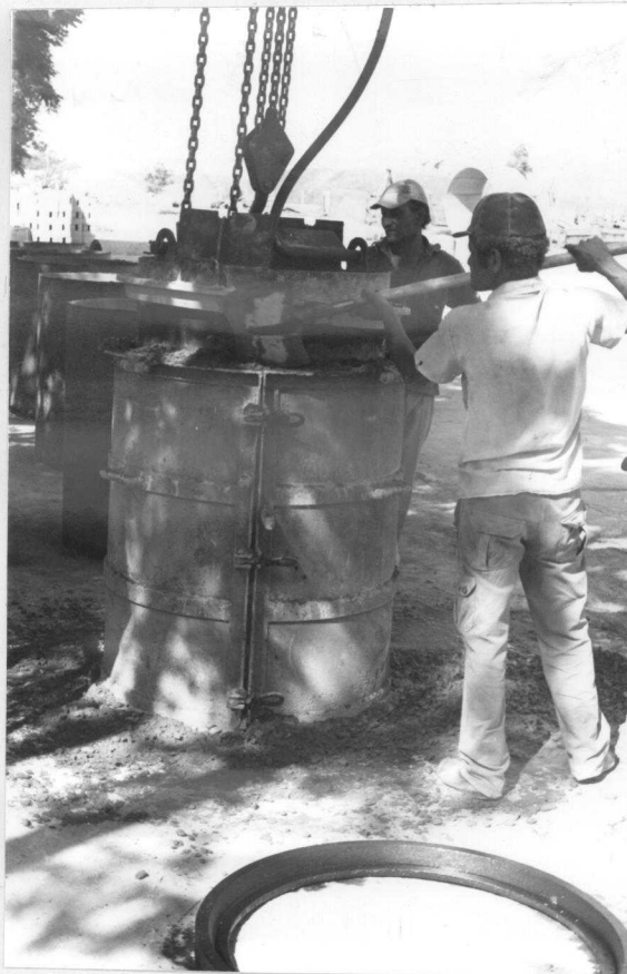
Foto 2.2 - Construção de tubo de concreto com adensamento por vibração - concretagem.
