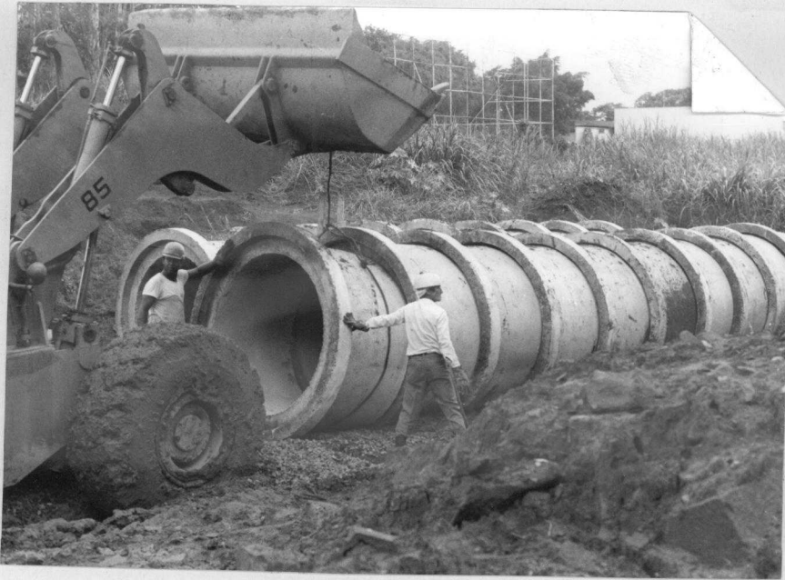
Foto 2.3 - Construção de galeria com tubos de concreto - colocação dos elementos.
