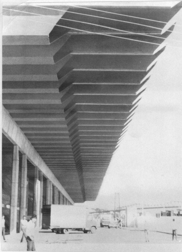
Foto 5.5 - Terminal rodoviário de Florianópolis - cobertura com elementos de argamassa armada 6 7 .
