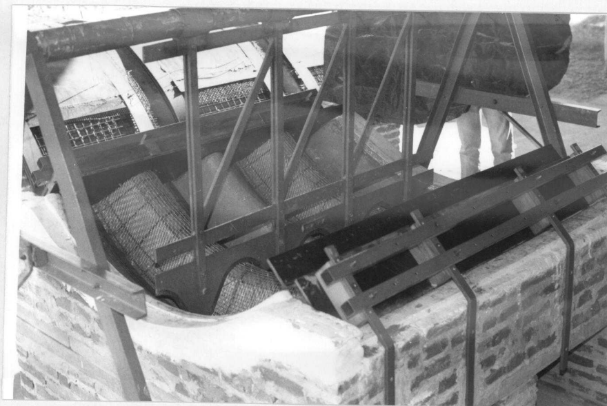
Foto 6.31 - Aspecto da armadura colocada na fôrma.
