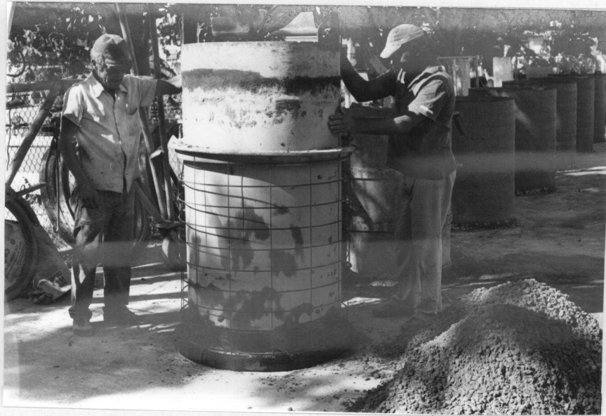
Foto 2.1 - Construção de tubo de concreto com adensamento por vibração - colocação da forma interna.
