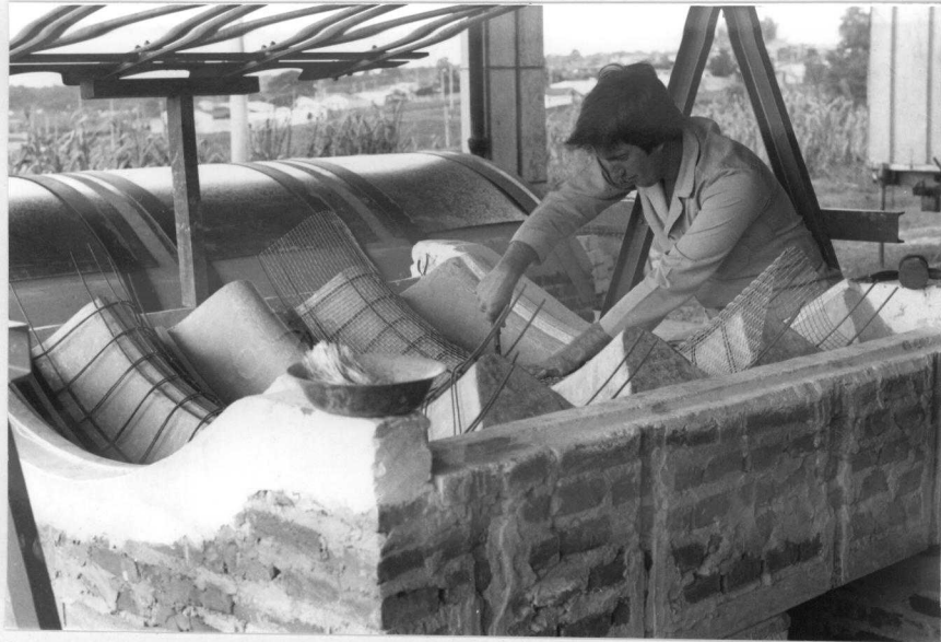
Foto 6.29 - Montagem da armadura do modelo 3, sobre a fôrma.
