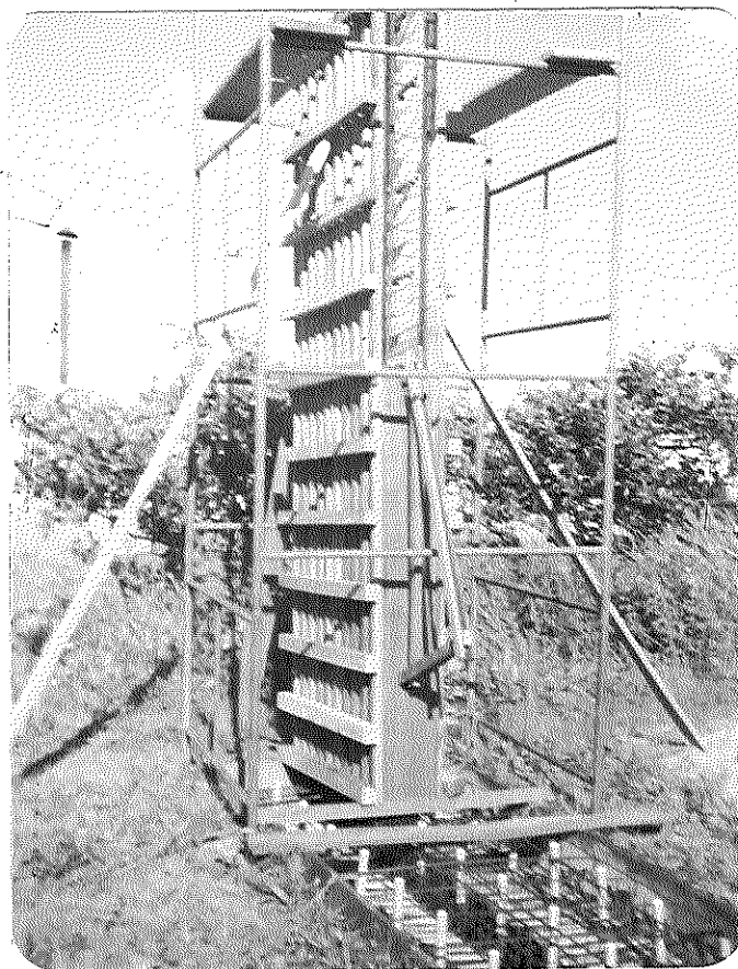
Foto 1 - Vista da Forma do Pilar antes da Concretagem
