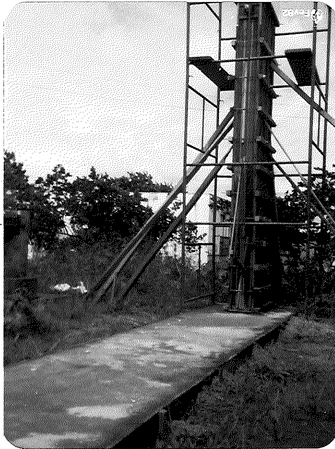
Foto 4 - Vista Geral da Forma do Pilar após a Concretagem
