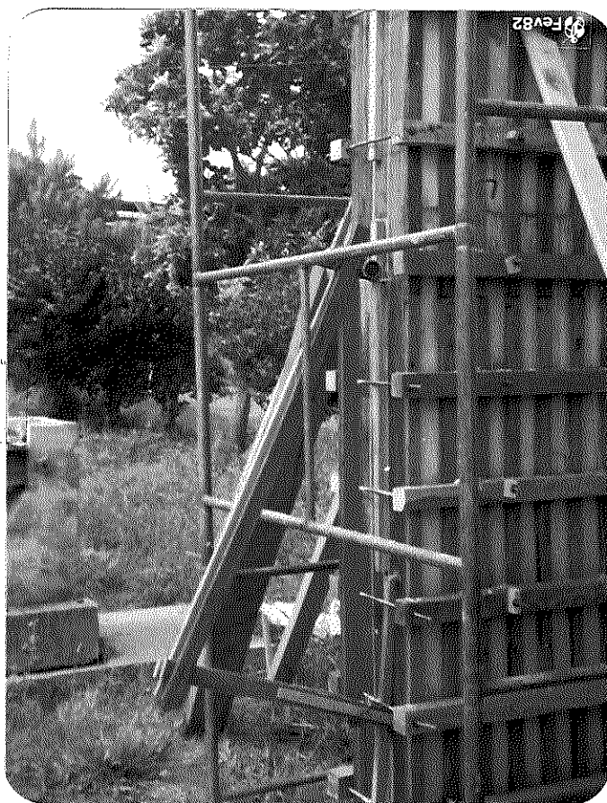
Foto 3 - Detalhe do Painei com Gravatas Progressivas
