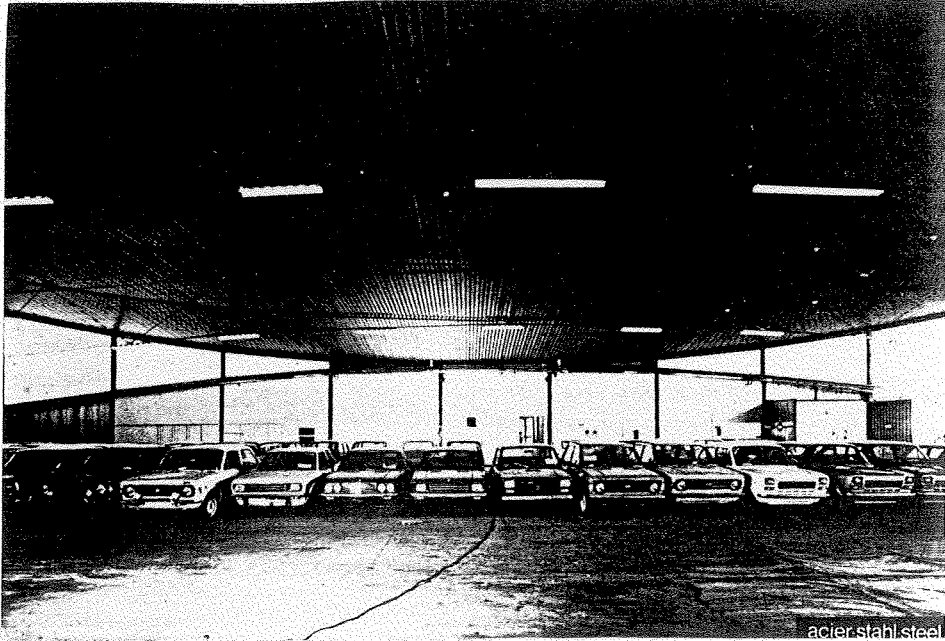
FIG. 1.31 - Vista do interior.
