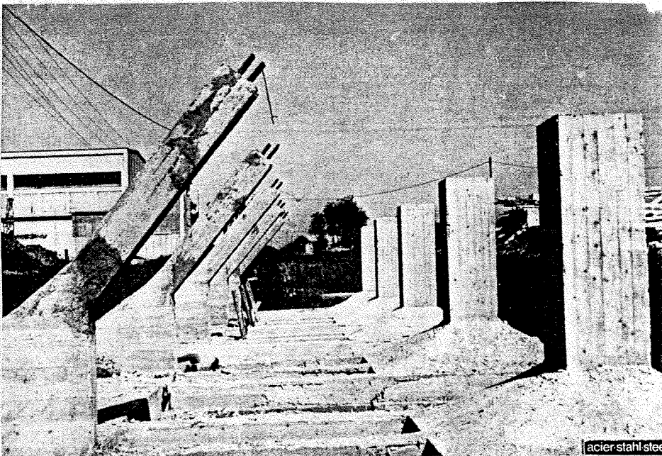
FIG. 1.9 - Detalhes das ancoragens dos cabos.
