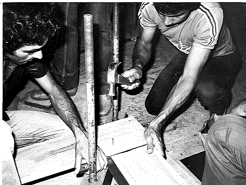
Fig. 6.4 - Verificação de Perpendicularidade e Fixações com dois pregos
