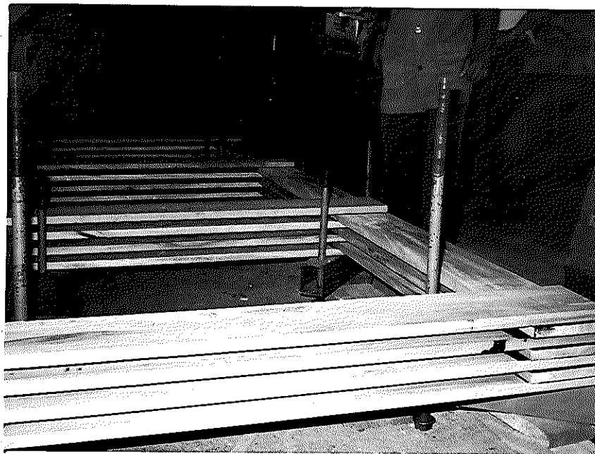
Fig. 6.8 - Viga Vierendeel Pronta
