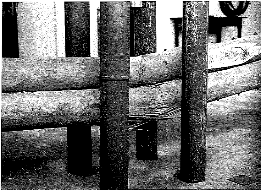
Fig. 89 Ruptura da Viga
