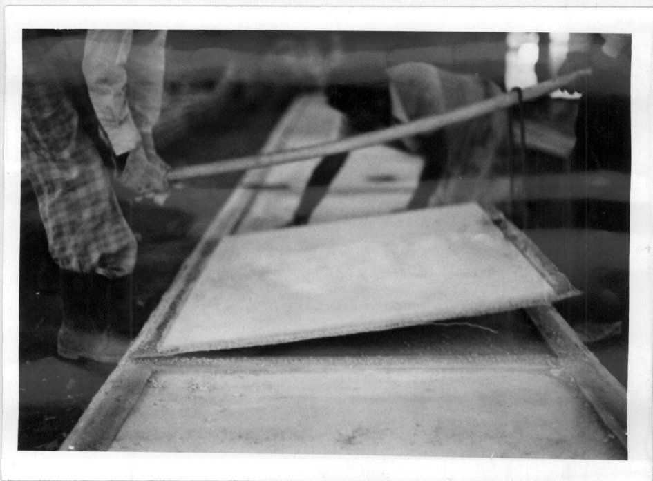
Fig. 3.5.12 - Retirada das placas, da base, através de gan ch o passado pela abertura das malhas.
