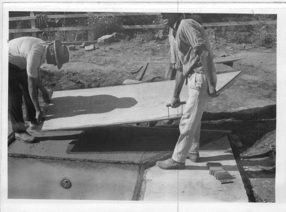
Fig. 3.1.5 - Montagem da placa "prainha" sobre a base preparada com brita nº 1 e camada de 3cm de argamassa magra.
