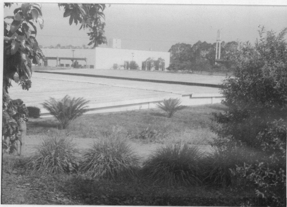
Fig. 4.10 - Vista parcial dos reservatórios
