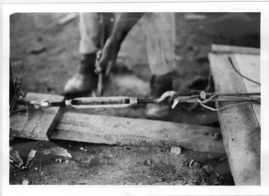
Fig. 3.5.5 - Operador tracionando os cabos do esticador pa ra manter a tela perfeitamente posicionada na forma.
