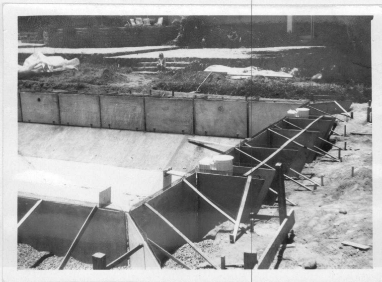
Fig. 3.1.3 - Montagem das placas "parede" e "gigante", na parte a ser aterrada, ligando-se as telas salientes.
