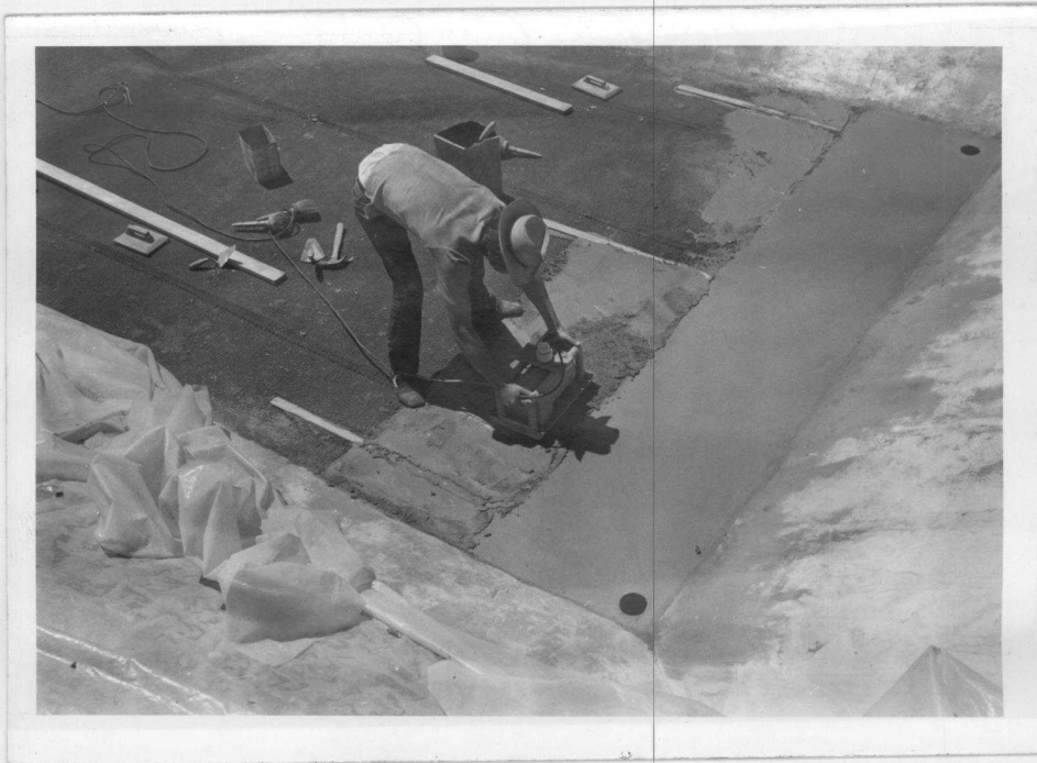
Fig. 3.1.12 - Enchimento do fundo. Notar as réguas guias para garantir-se a espessura fixada.
