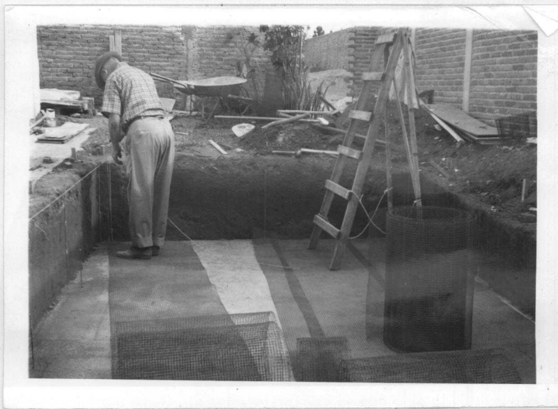
Fig. 3.4.15 - Colocação da armadura de fundo
