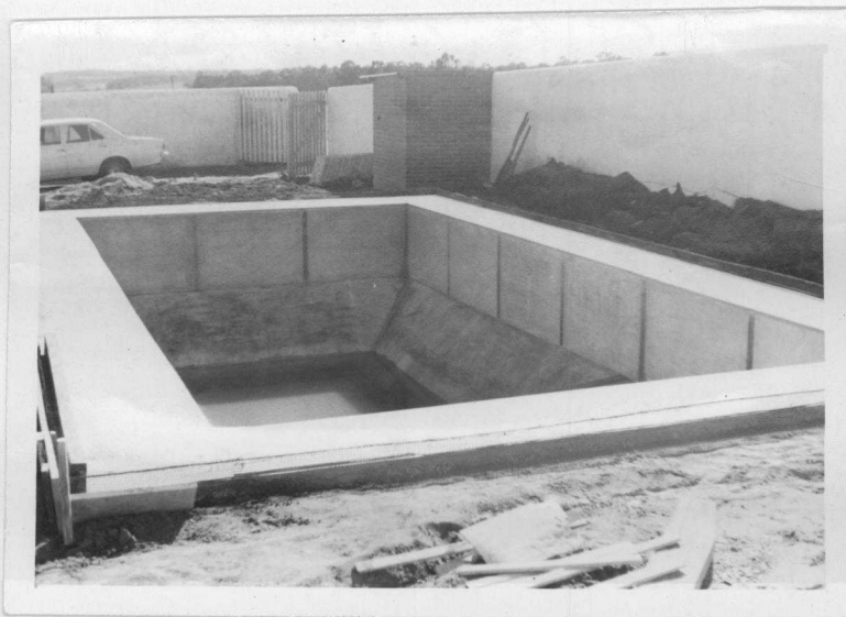
Fig. 3.3.3 - Aspectos finais da construção - Lado fundo
