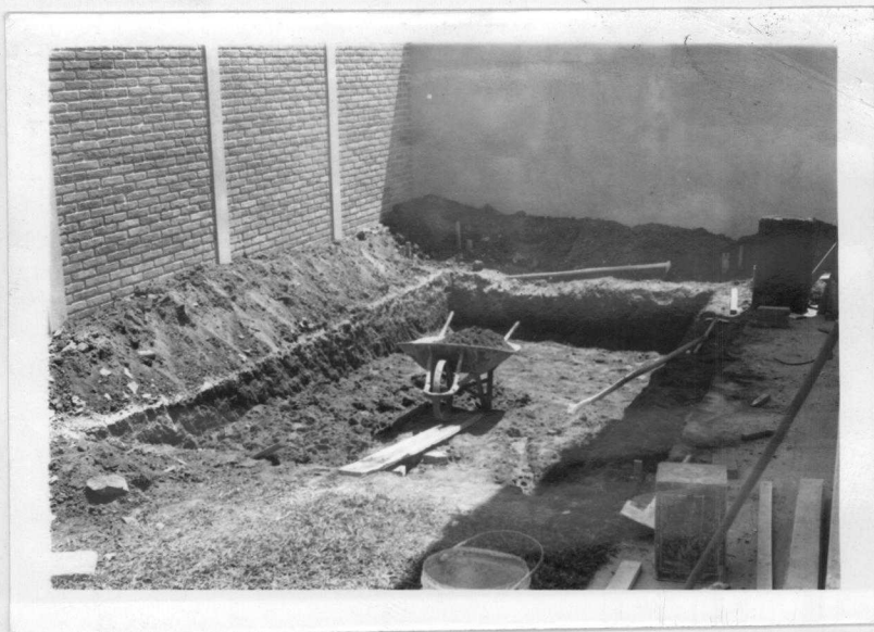
Fig. 3.4.10 - Fase inicial da escavação
