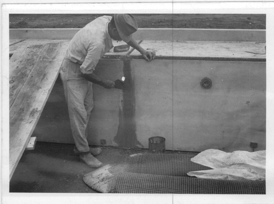
Fig. 3.1.7 - Execução da junta "parede-gigante".
