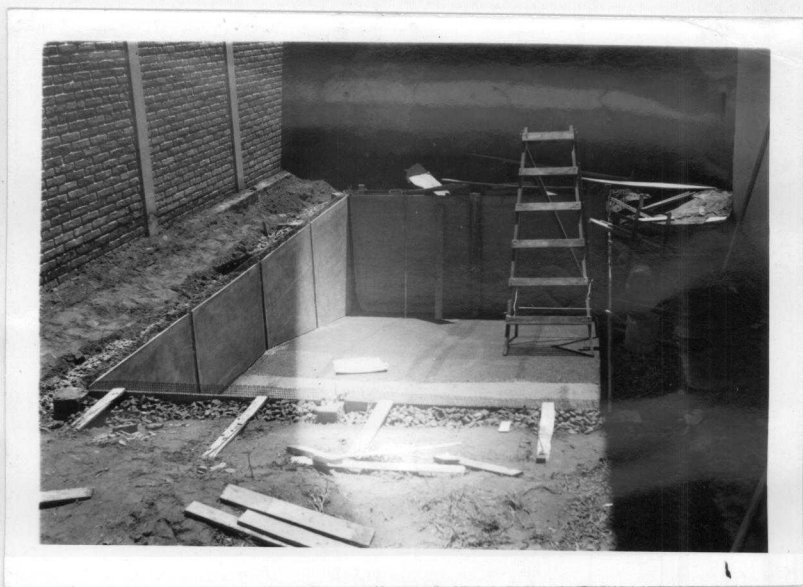
Fig. 3.4.18 - Aspecto final da montagem das placas, já tendo sido concretados os pilaretes.
