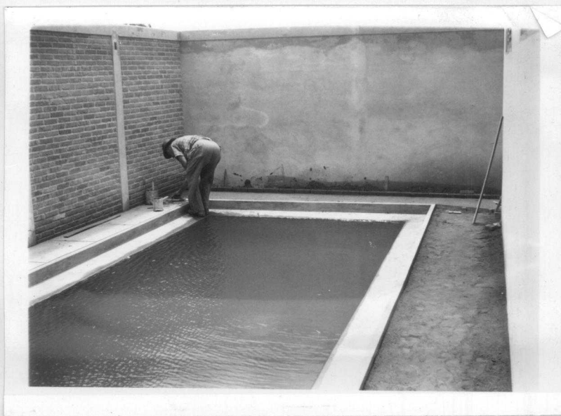
Fig. 3.4.23 - Acabamentos finais. A estanqueidade foi perfeita.
