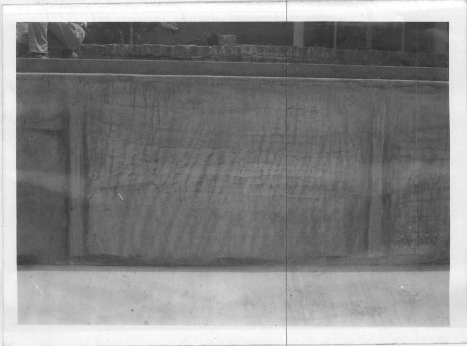
Fig. 3.1.9 - Aspecto final das juntas, notando-se o perfeito acabamento.
