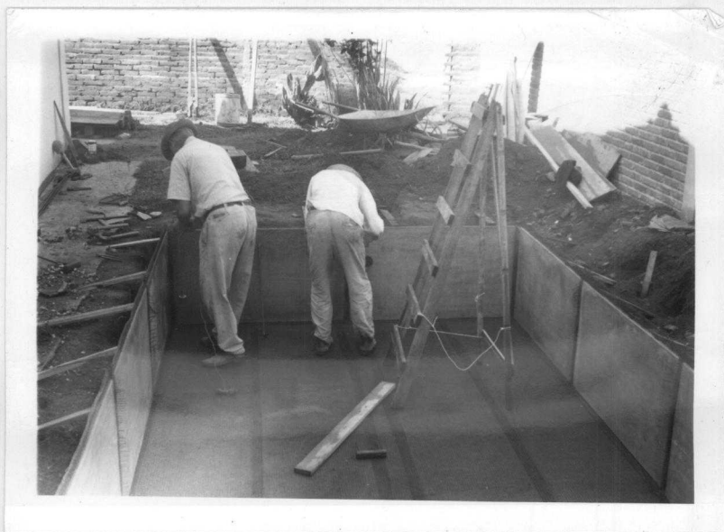
Fig. 3.4.17 - Montagem e escoramento das placas "parede"
