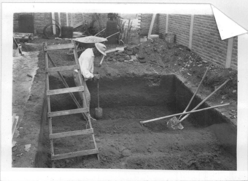
Fig. 3.4.12 - Apiloamento do fundo com maço de 30kg
