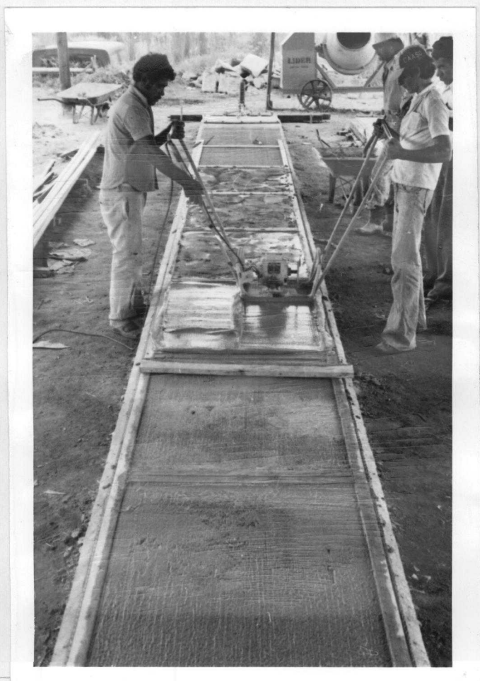
Fig. 3.5.8 - Início da moldagem das placas
