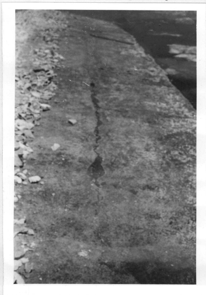
Fig. 3.2.7 - Fissura da "prainha" no encontro com o "gigante". Uma presença constante.
