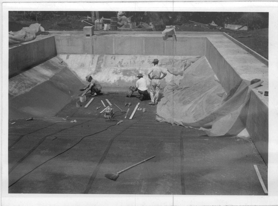
Fig. 3.1.13 - Execução dos taludes do fundo. Notar os cuidados com a proteção da argamassa fresca.
