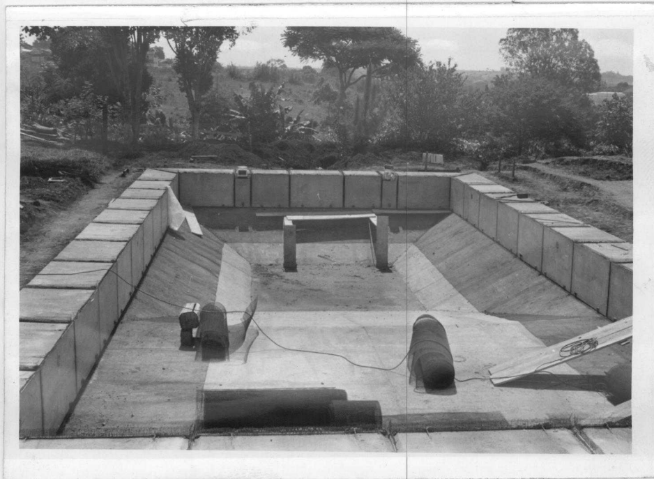
Fig. 3.1.6 - Aspecto final da montagem das peças pré-fabricadas, notando-se as juntas ainda não executadas. Note-se também que já foram estendidas as telas na zona de ligação "parede-fundo".
