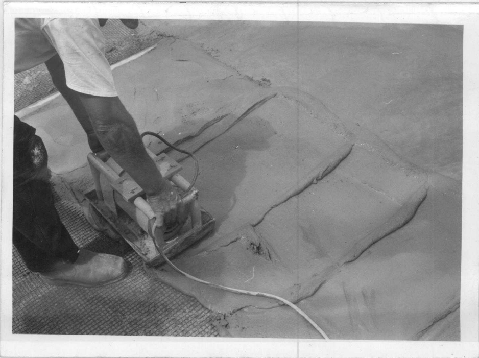
Fig. 3.1.11 - Enchimento do fundo. A argamassa é forçada através da tela pelo vibrador de placa. Note-se o aspecto "rico" da argamassa.
