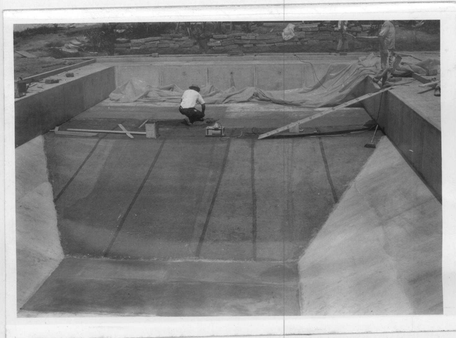
Fig. 3.1.14 - Execução da parte rasa, notar os cuidados com a proteção da argamassa.
