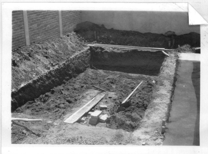
Fig. 3.4.11 - A escavação já toma, aproximadamente, a forma final.
