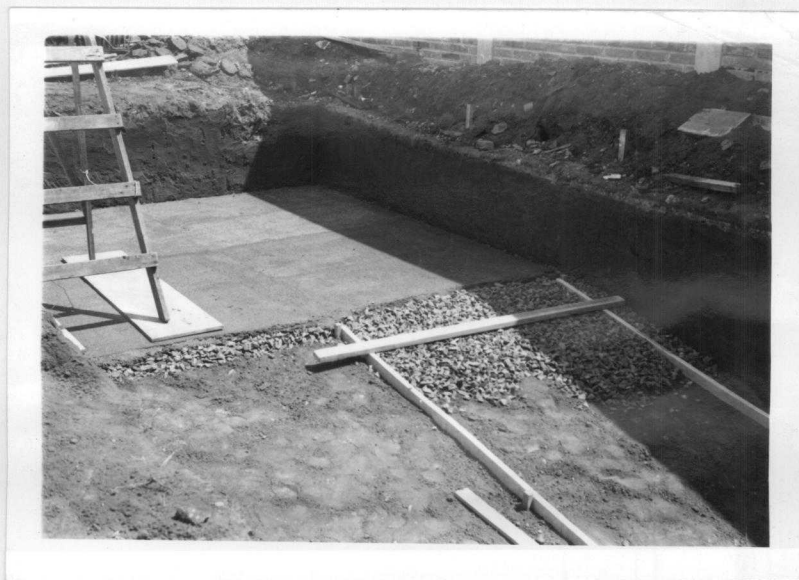
Fig. 3.4.14 - Revestimento da drenagem com argamassa magra
