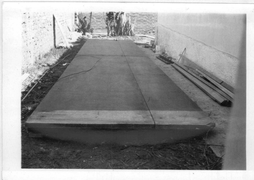
Fig. 3.4.3 - Base de madeira, sobre a qual foram pré-fabricadas as placas.
