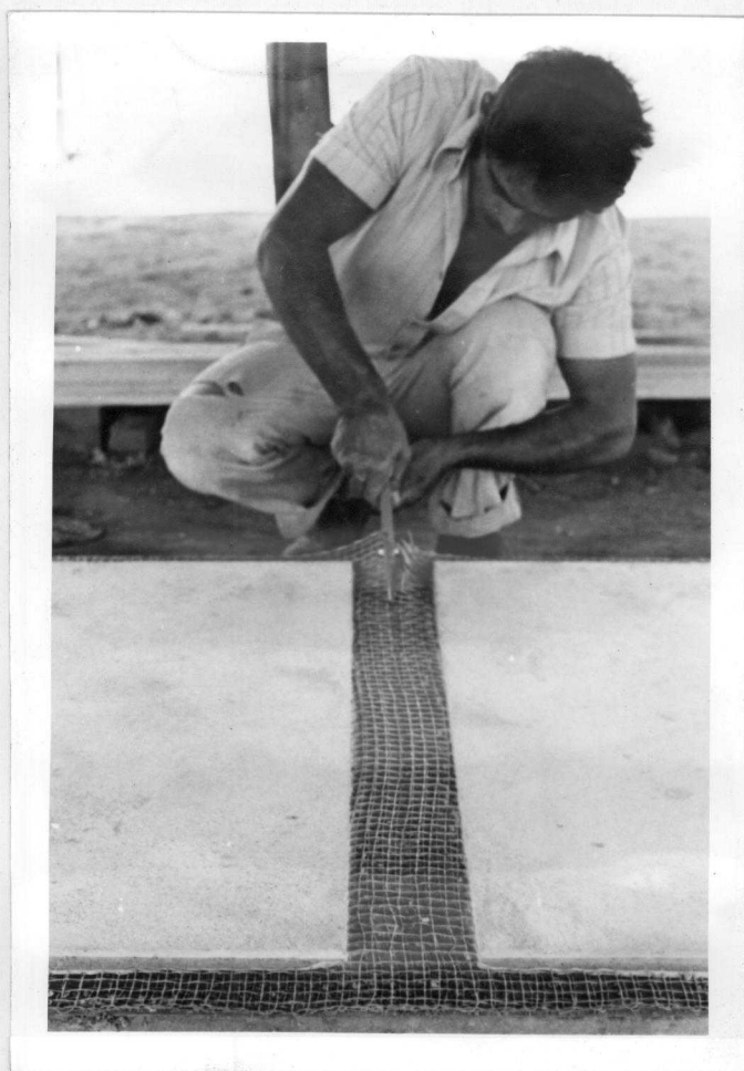
Fig. 3.5.11 - Corte das telas salientes, após cura e desforma.
