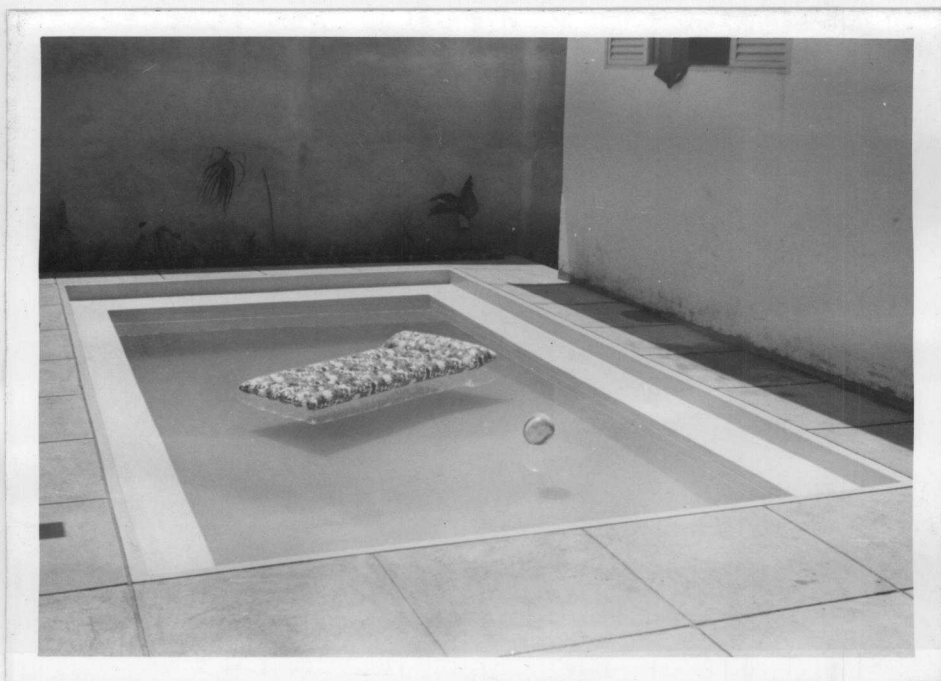
Fig. 3.4.24 - Vista global da piscina acabada
