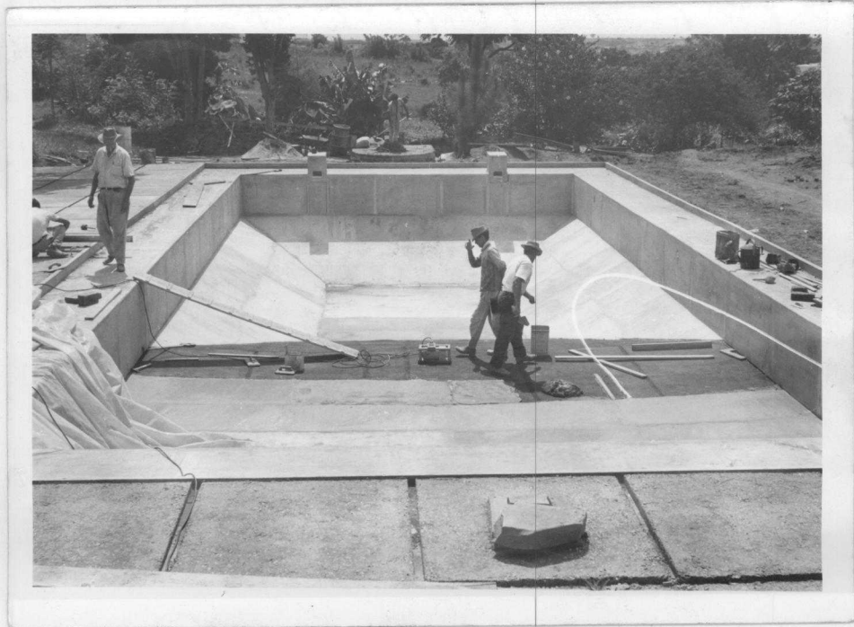
Fig. 3.1.15 - Aspecto final dos trabalhos.
