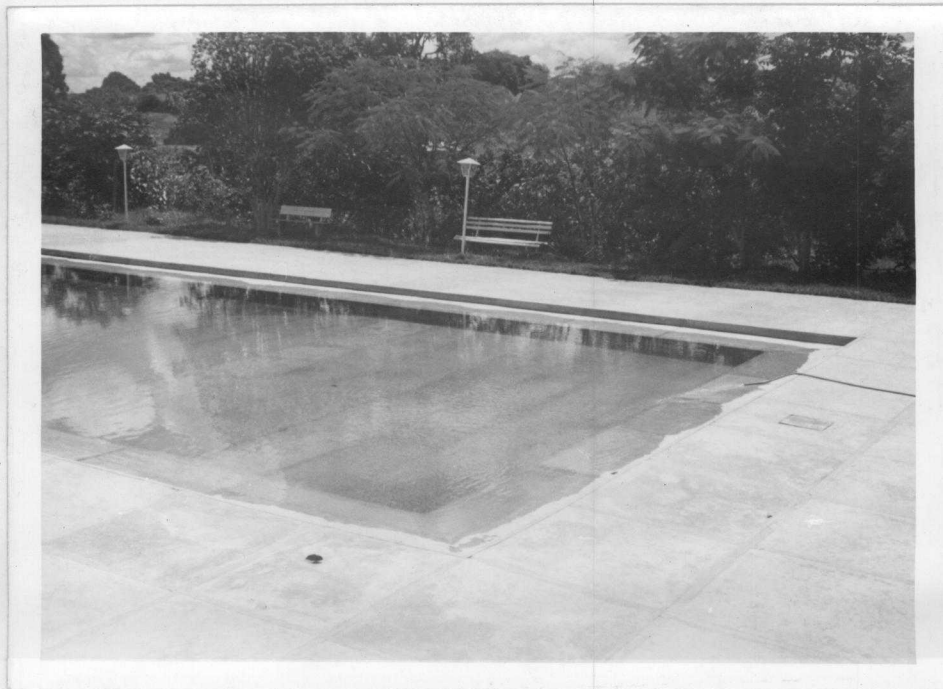
Fig. 3.1.17 - Vista parcial da parte rasa. A piscina não havia, ainda, sido pintada, podendo-se notar as marcas das juntas.
