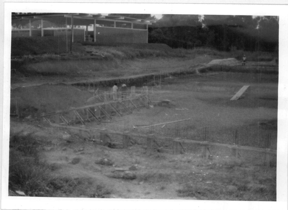
Fig. 3.5.17 - Pilaretes da seção de maior profundidade, com a parte inferior já concretada.
