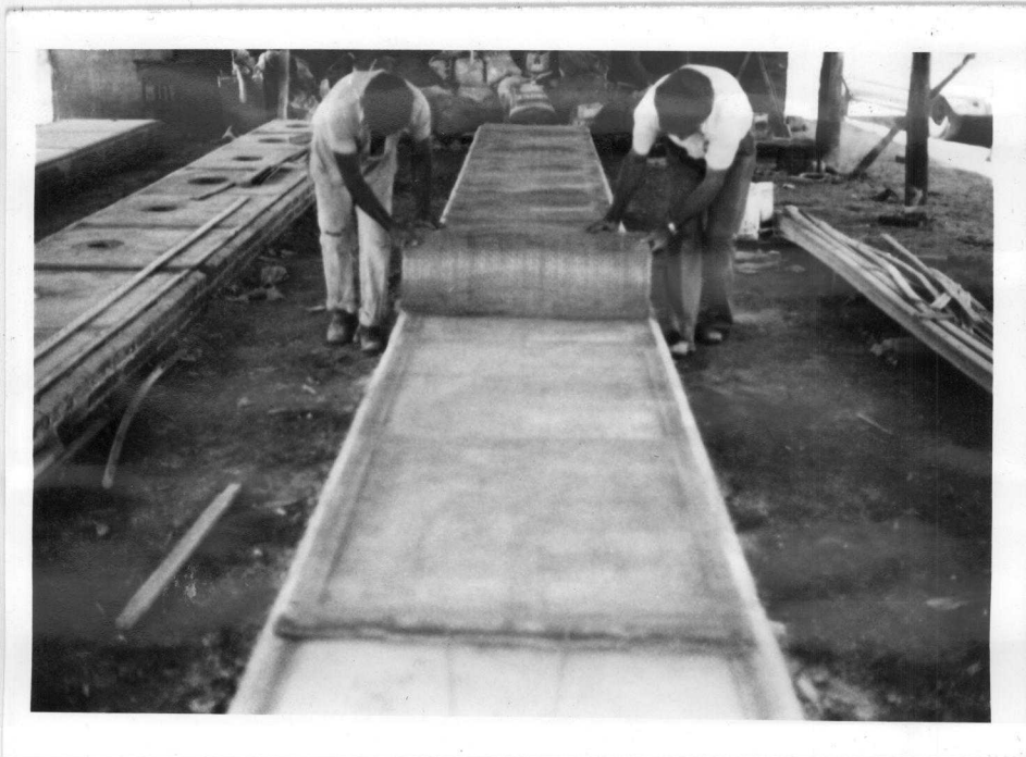
Fig. 3.5.4 - Tela da armadura das placas "parede", sendo de senrolada sobre a forma preparada.
