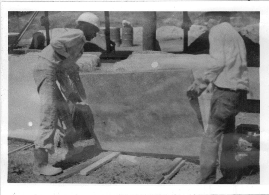
Fig. 3.5.13 - Estocagem das peças pré-fabricadas para com pl ementação da cura.
