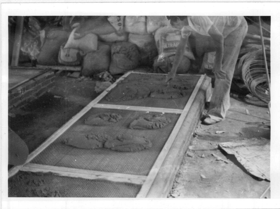
Fig. 3.5.8 - Início da moldagem das placas
