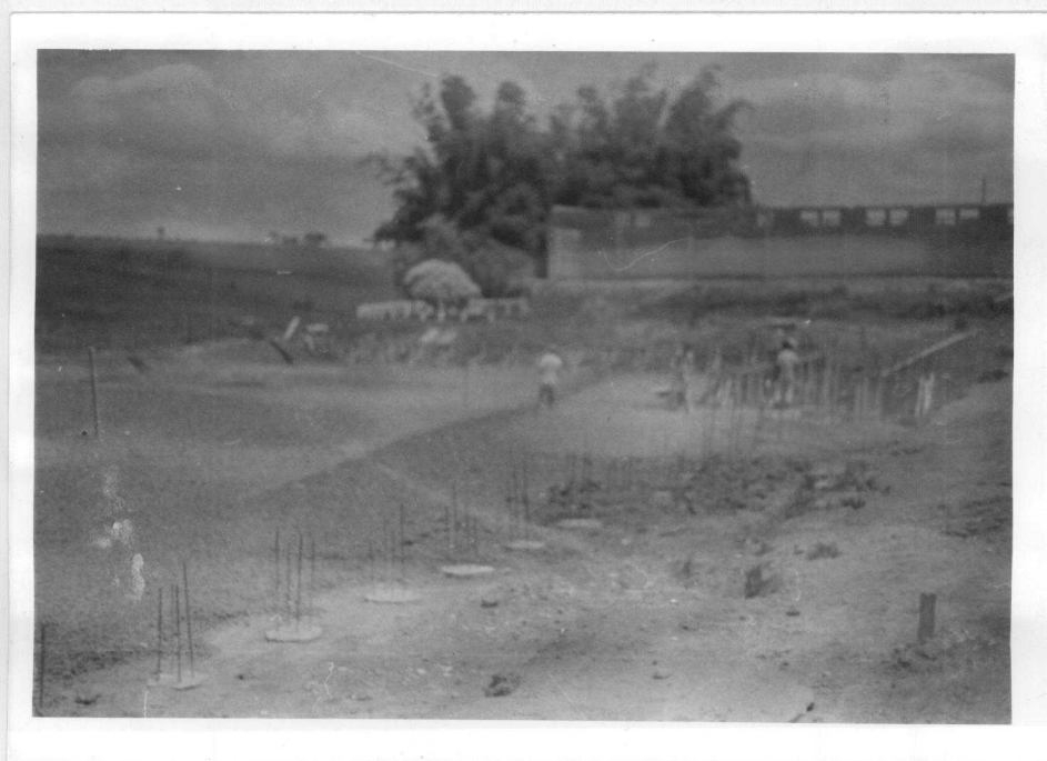
Fig. 3.5.18 - "Brocas" concretadas na seção rasa, notando-se os arranques dos pilaretes.
