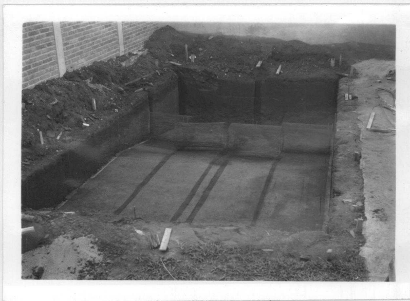
Fig. 3.4.16 - Fase final da armação do fundo. Notem-se as emendas das telas.
