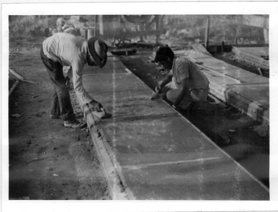
Fig. 3.5.10 - Acabamento com desempenadeira
