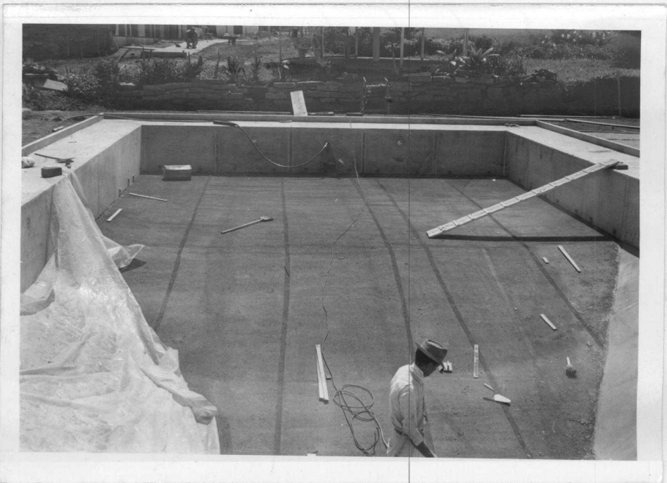
Fig. 3.1.10 - Armação do fundo já executada. Note-se a emenda das telas por superposição.
