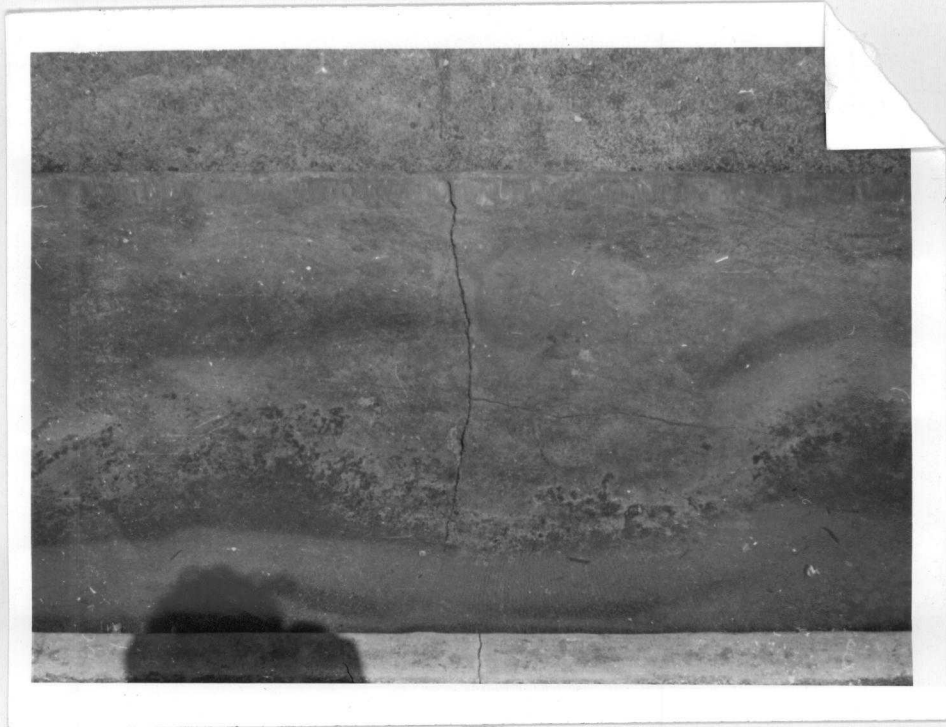
Fig. 3.2.7 - Fissura da "prainha" no encontro com o "gigante". Uma presença constante.
