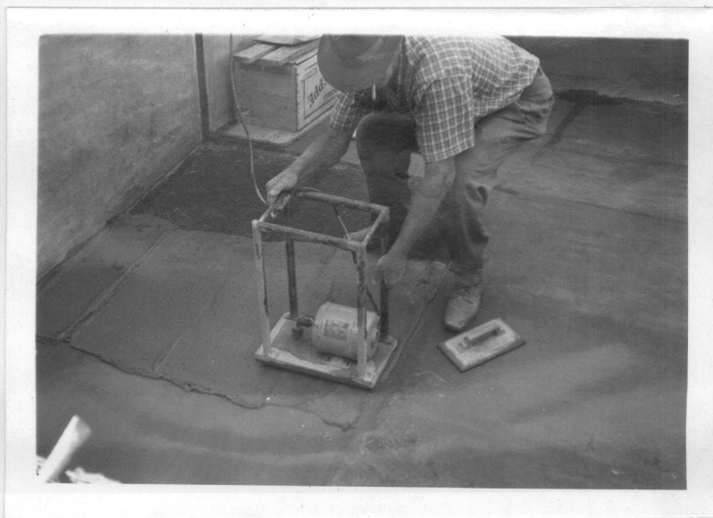
Fig. 3.4.20 - Final da moldagem do fundo
