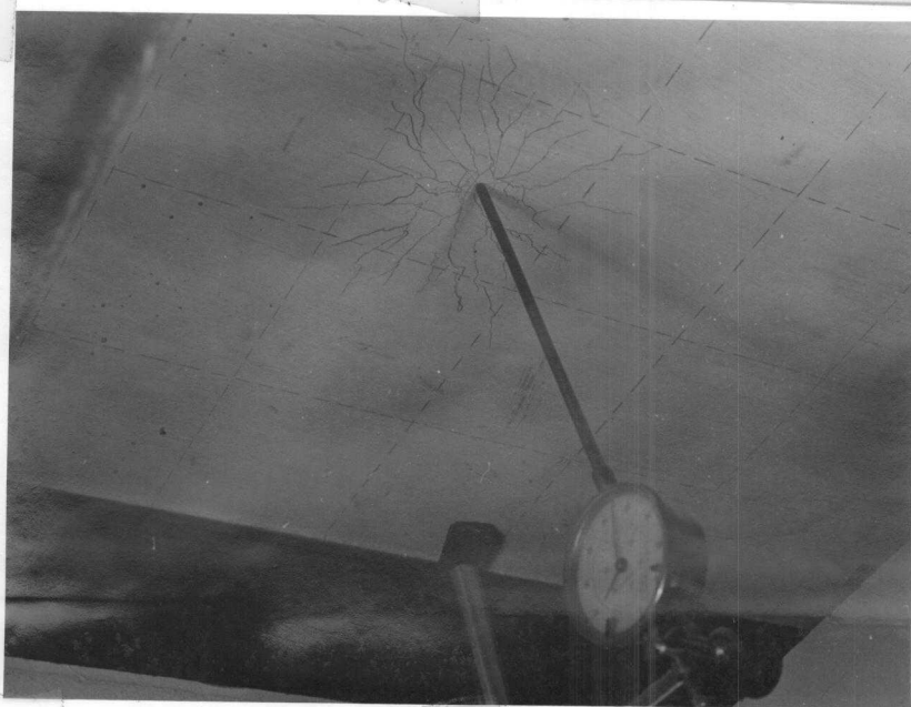
Foto 4 - Primeiras fissuras da face inferior de uma das lajes ensaiadas.
