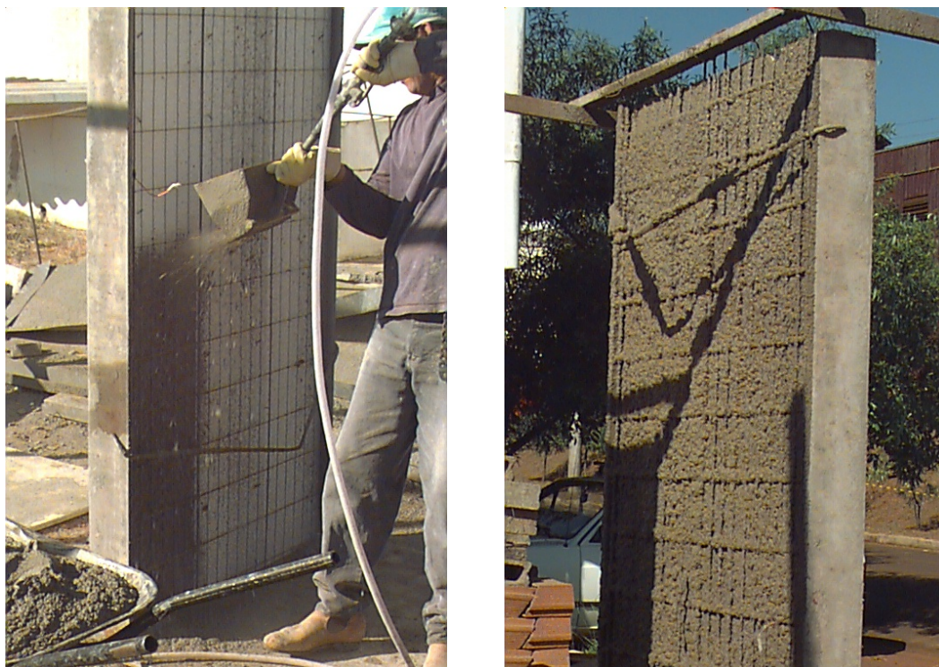
Figura 5 – Primeira etapa da projeção da argamassa
