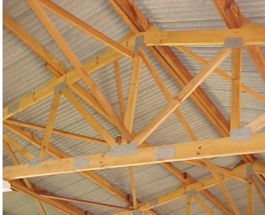
Figura 1 – Estrutura de cobertura executada com CDE's como elemento de união nas ligações
