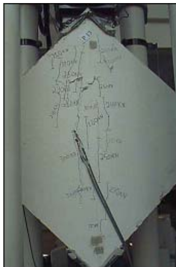
Figura 3.6 – Fissuras na parede revestida com telas + conectores 1.
