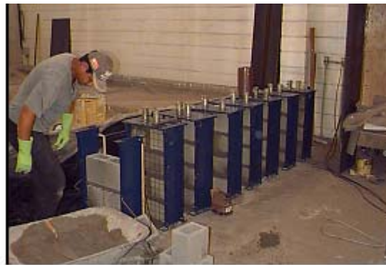
Figura 2.11 - Vista das paredinhas sendo confeccionadas.
