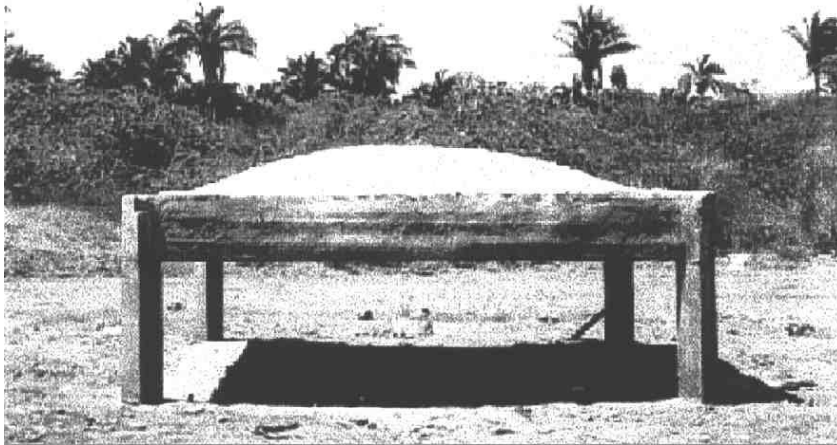
Figura 20 - Vista do protótipo concluído
